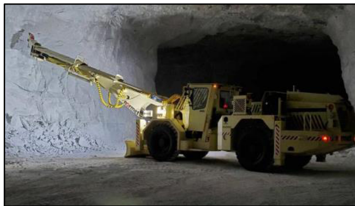
Figura 16 - Equipamento tipo Scaler em operação
