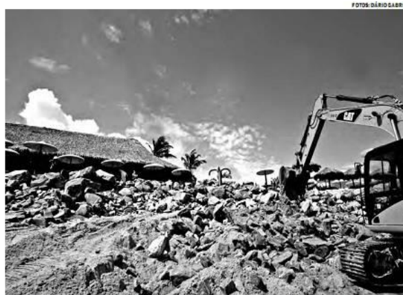
Figura 5 - Escavadeira na praia do Icaraí
