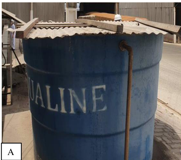
Figura 5A e 5B – Verificação de reservatórios de água próximos aos silos, com cobertura inadequada, permitindo frestas que favorecem a contaminação da água
