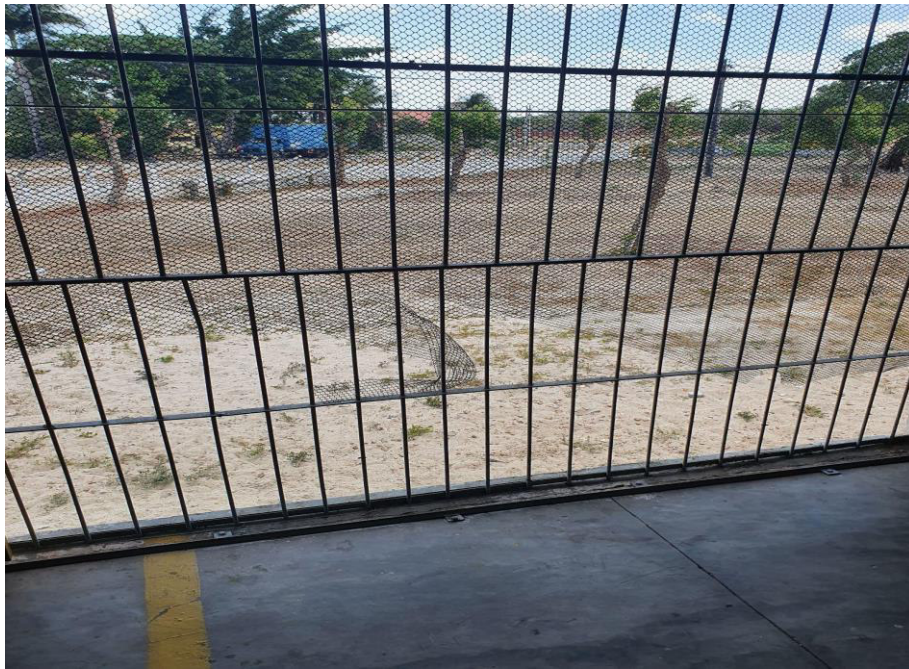
Figura 9 – Rasgos na tela do galpão de armazenamento de estabelecimentos visitados durante o período de estágio
