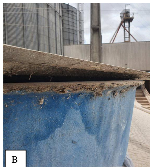
Figura 5A e 5B – Verificação de reservatórios de água próximos aos silos, com cobertura inadequada, permitindo frestas que favorecem a contaminação da água
