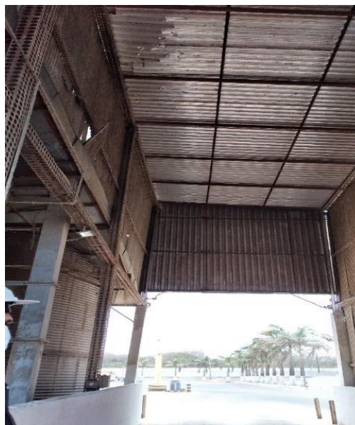
Figura 6 – Aberturas e acúmulos de sujeiras nos telhados das áreas de recepção de alimentos de estabelecimentos visitados durante o período de estágio no MAPA
