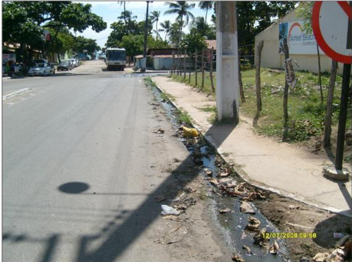
Figura 35: Esgoto a céu aberto contribuindo para a poluição dos recursos hídricos.
