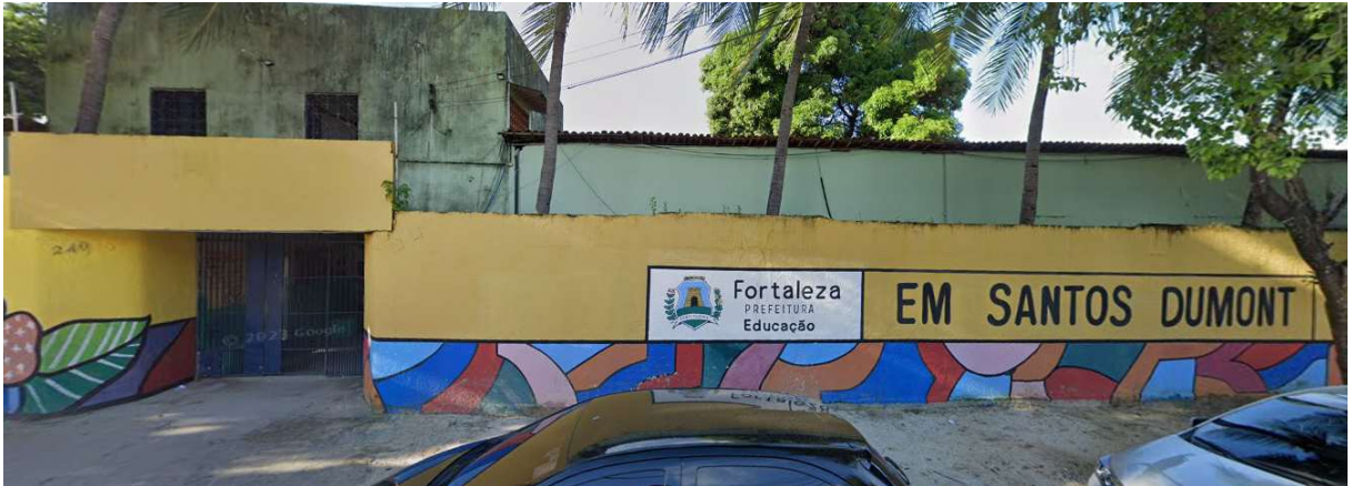
Figura 3 - Fachada da EMEIEF Santos Dumont.
