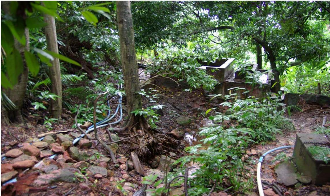
**FIGURA 16** - Sistema de alocação de água da Fonte Batateira, usando como parâmetro de medida a unidade de vazão portuguesa denominada “telha”.
