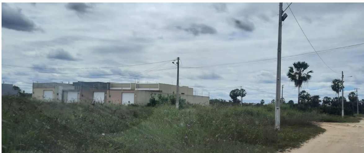
Figura 22 – Loteamento próximo ao lixão
