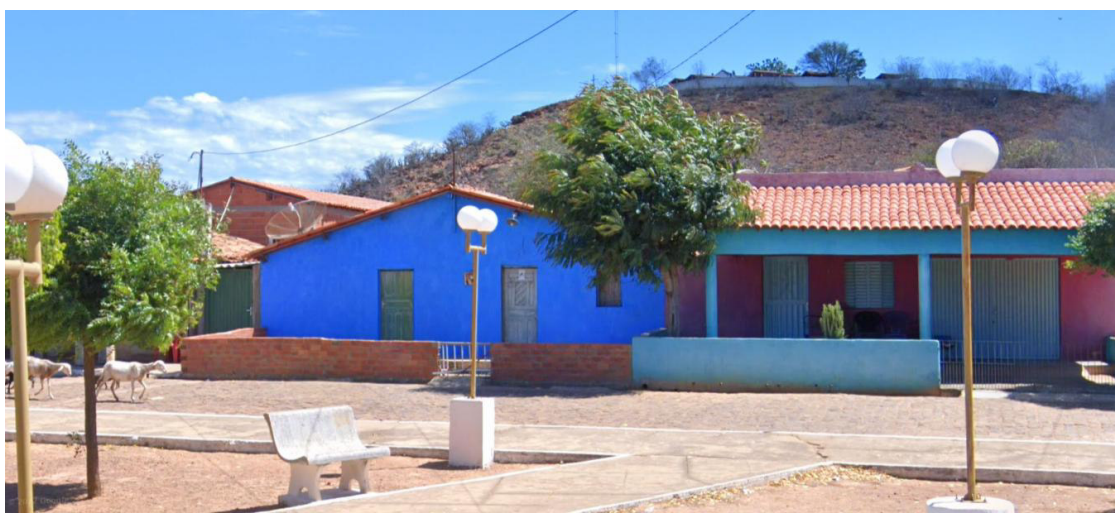
Figura 10 - Imagem das casas no Google Street
