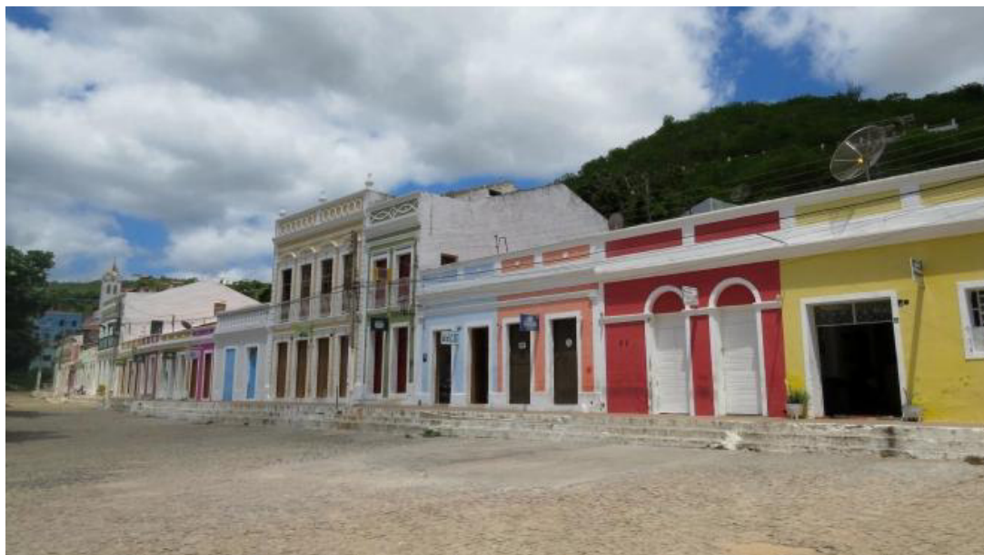
Figura 43 - Construções na cidade de Piranhas em Alagoas
