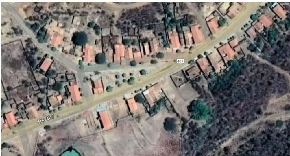
Figura 33 - Imagens de satélite da pavimentação da cidade
