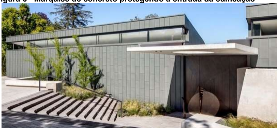
Figura 6 - Marquise de concreto protegendo a entrada da edificação
