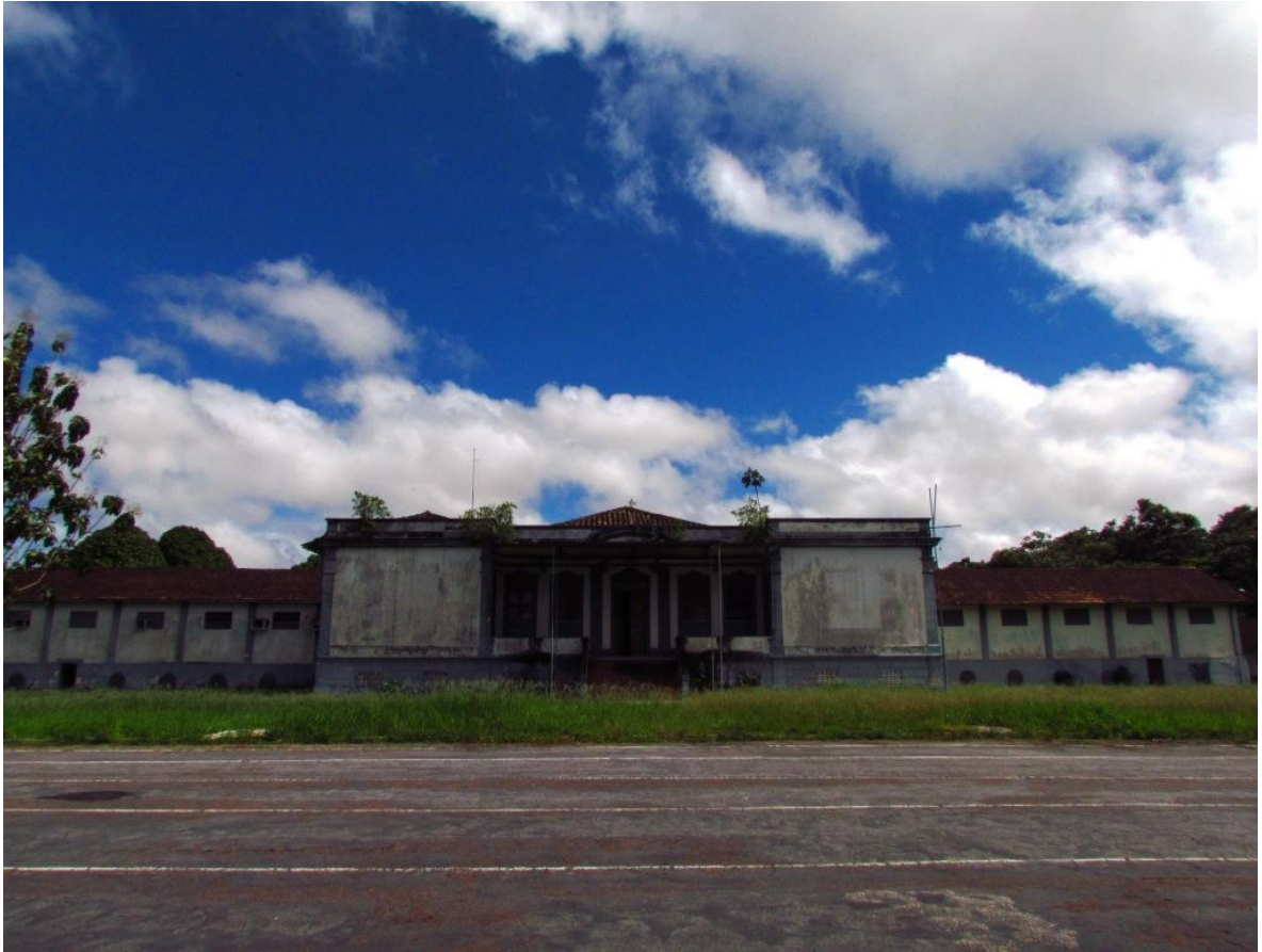
Atual instalação do outrora Patronato Agrícola Manoel Barata. Outeiro, 16/03/2012.
