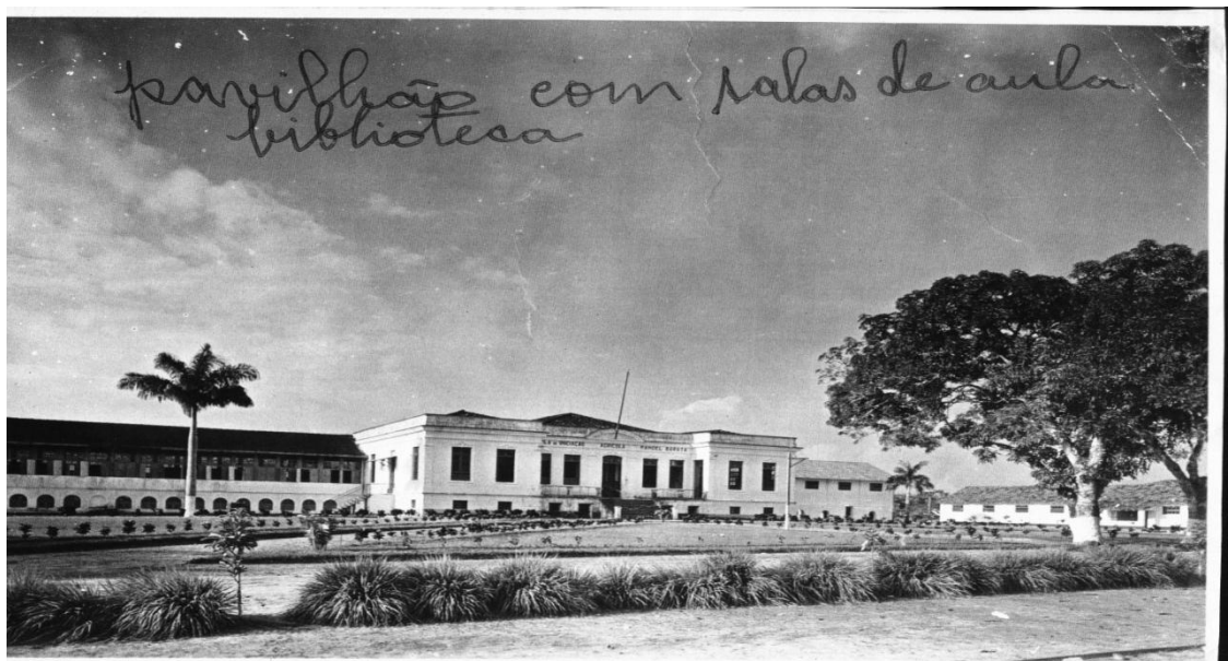
Patronato Agrícola Manoel Barata- Outeiro (Pará) Fonte: Arquivo do DDE. Sem data de Registro
