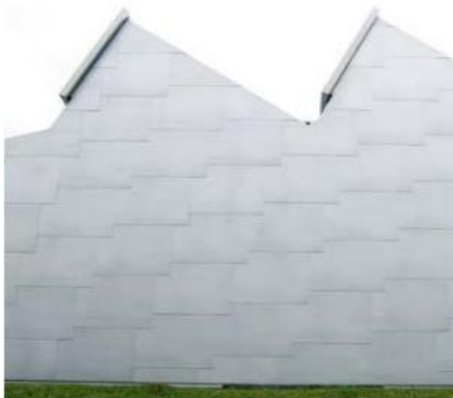
Figura 27 – Revestimento Externo em Aço inoxidável.
