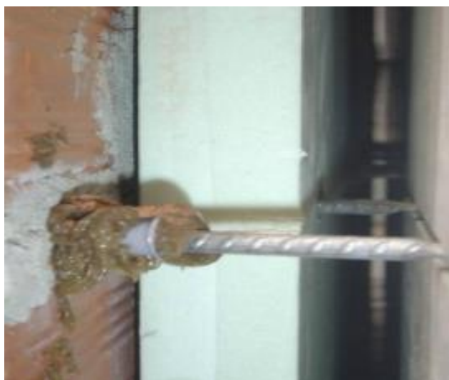
Figura 57 - Ancoragem por selagem.
