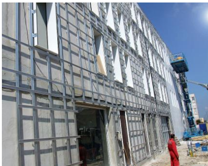
Figura 58 - Estrutura intermediária de alumínio.
