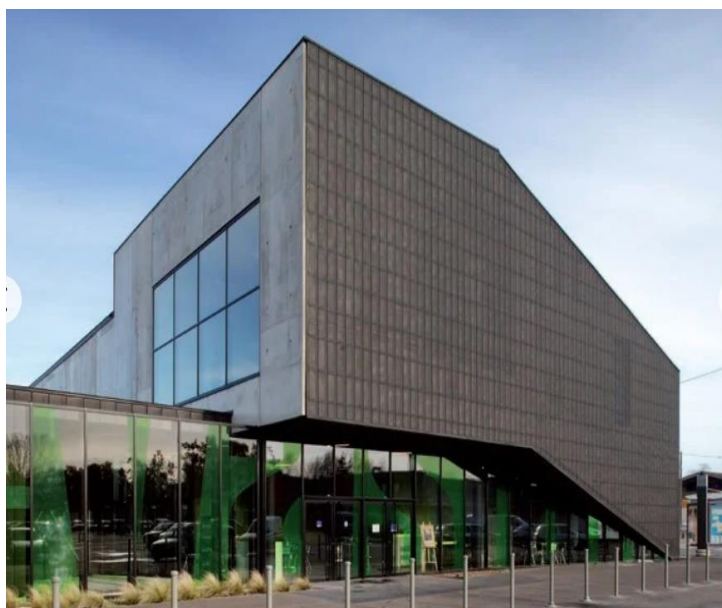
Figura 33 - Revestimento externo em Zinco.
