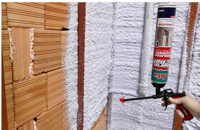
Figura 21 - Poliuretano projetado - Aplicação
