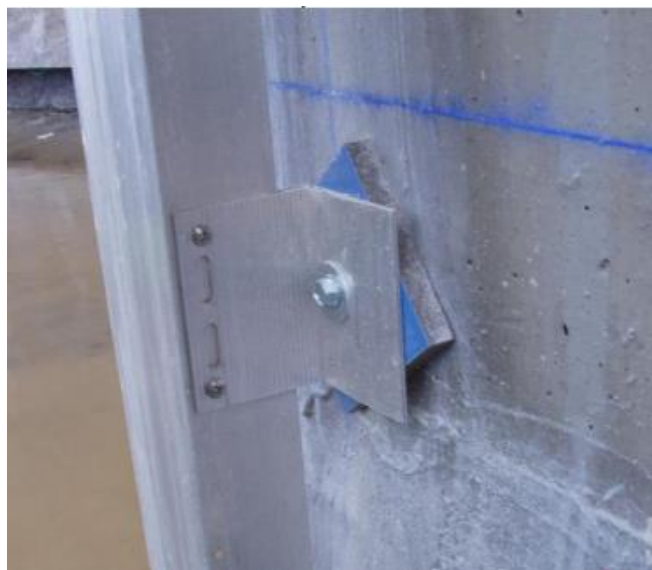
Figura 41 - Fixação da ancoragem.
