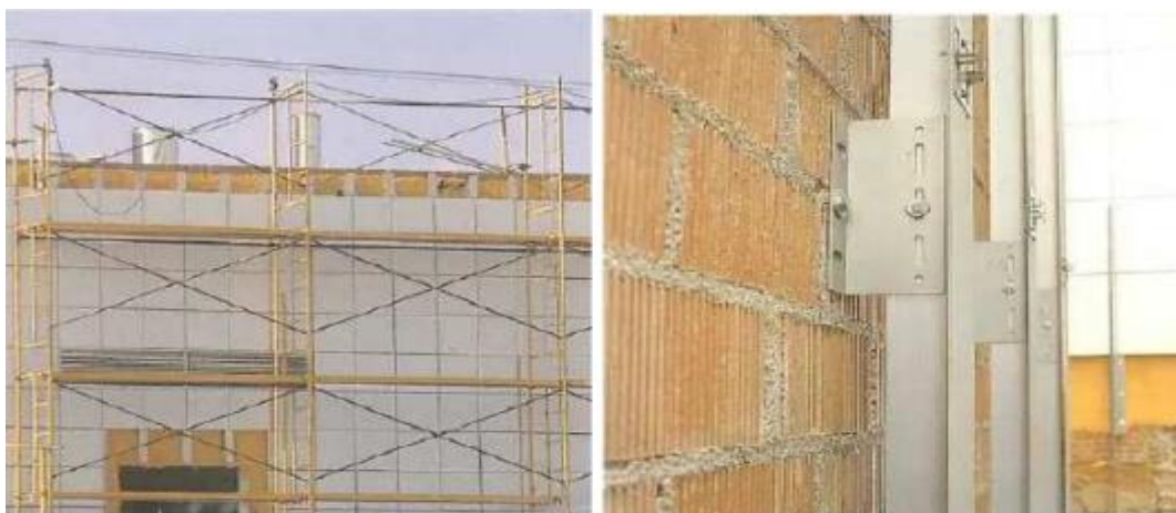
Figura 54 - Fachada montada in loco .
