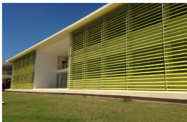
Figura 30 – Revestimento externo em Alumínio - Painel Perfilado.
