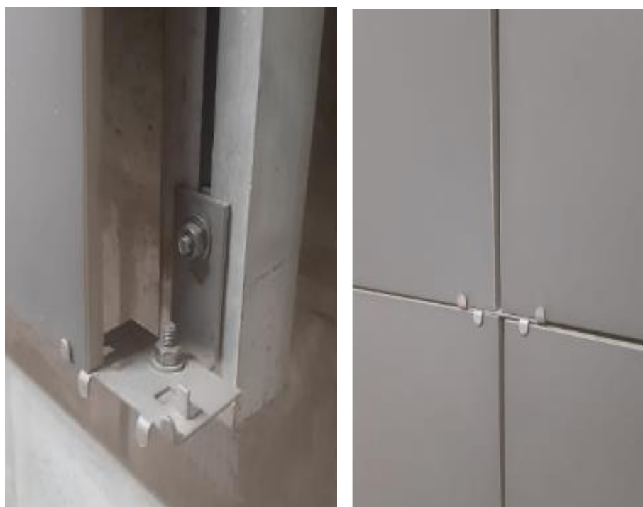
Figura 68 - Fixação do revestimento
