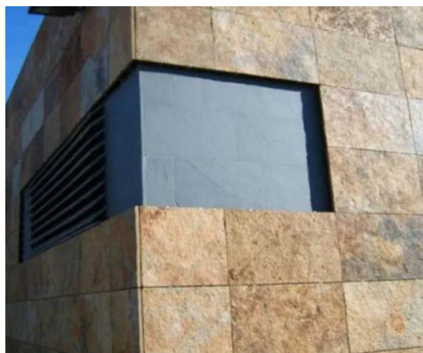
Figura 25 – Revestimento externo em pedra
