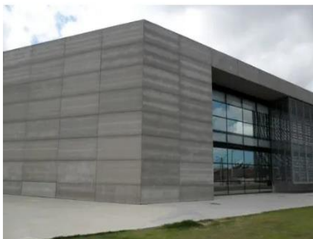
Figura 35 - Revestimento externo em naturocimento.
