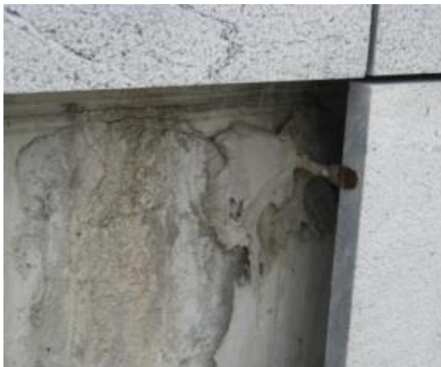
Figura 56 - Ancoragem mecânica
