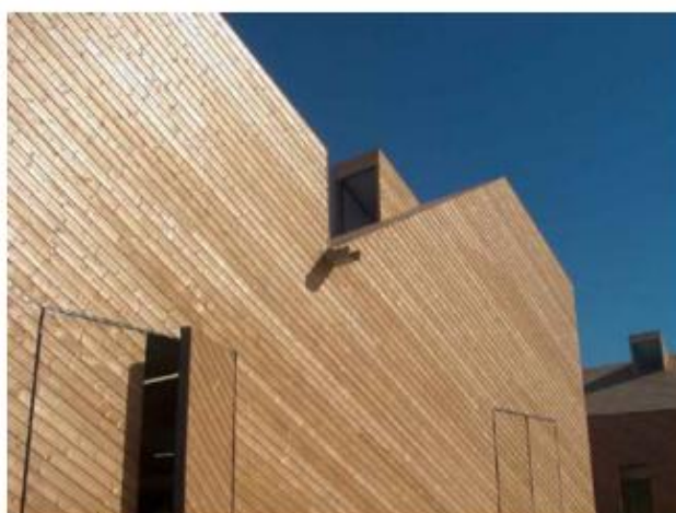
Figura 37 - Revestimento externo em Madeira Modificada.
