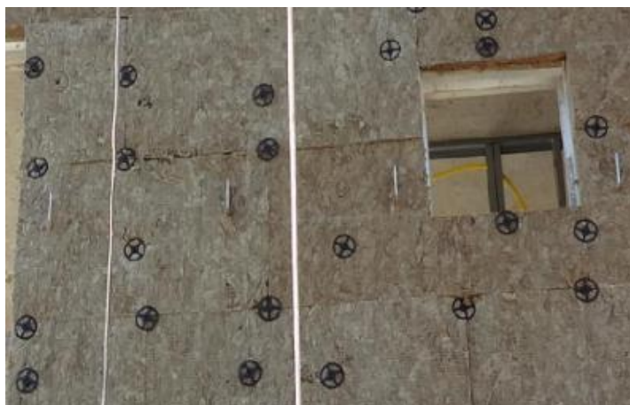
Figura 43 - Instalação do isolante térmico
