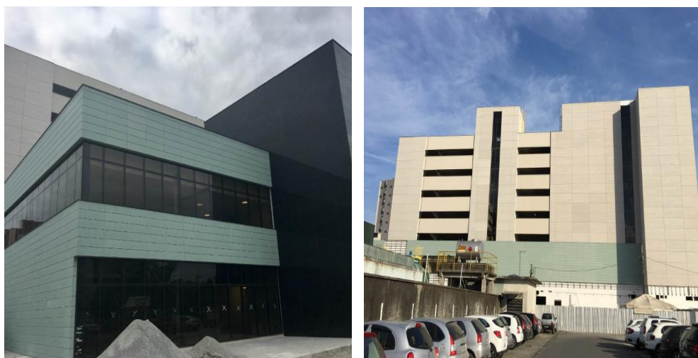
Figura 46 - Hospital Unimed - Revestimento cerâmico extrudado, fibrocimento e granito.
