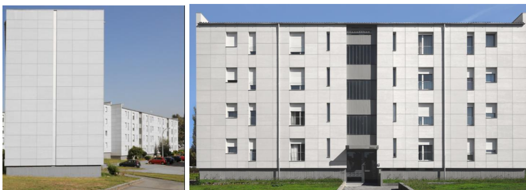
Figura 51 - Bairro Sobreiro - Retrofit de fachada.
