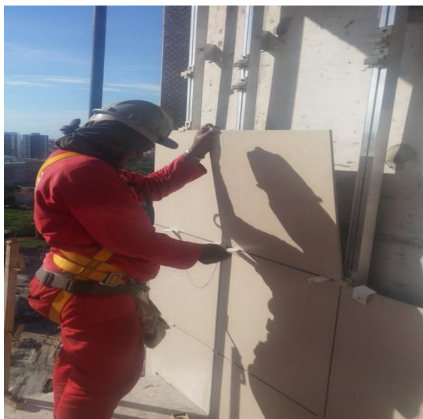
Figura 45 - Instalação do revestimento.
