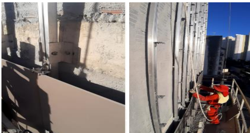
Figura 66 - Sistema de ancoragem fixado a estrutura de concreto
