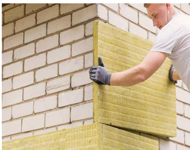
Figura 19 - Aplicação de Lã Mineral.
