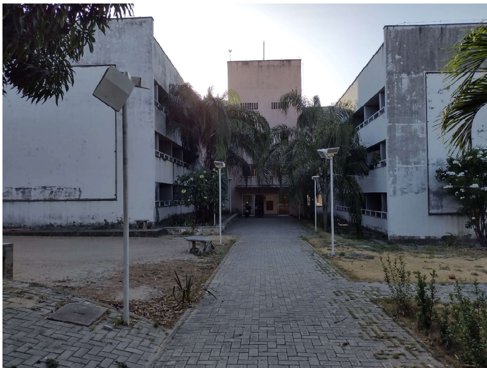
Figura 4 – Fachada da edificação
