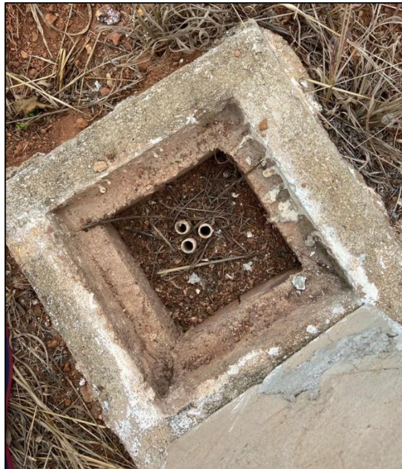
Figura 21 – Detalhe de um piezômetro da barragem
