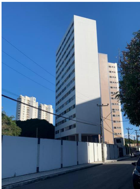
Figura 7 – Foto do Edifício 5
