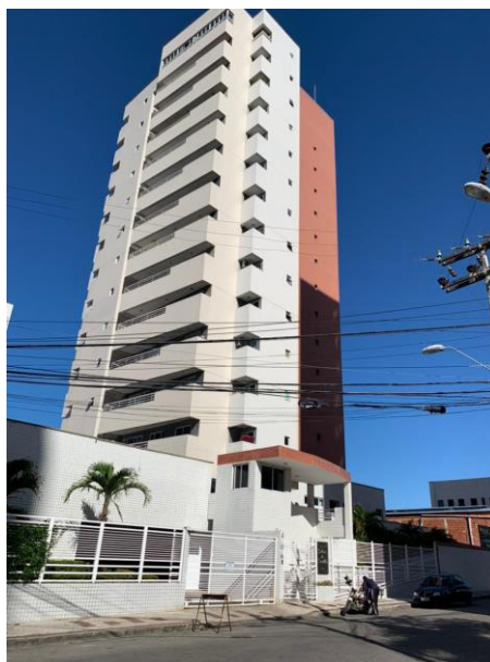
Figura 10 – Foto do Edifício 8
