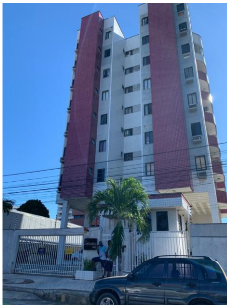
Figura 6 – Foto do Edifício 4
