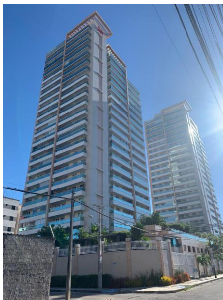
Figura 12 – Foto do Edifício 10
