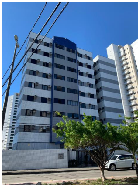
Figura 4 – Foto do Edifício 2
