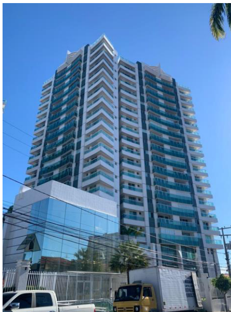
Figura 13 – Foto do Edifício 11
