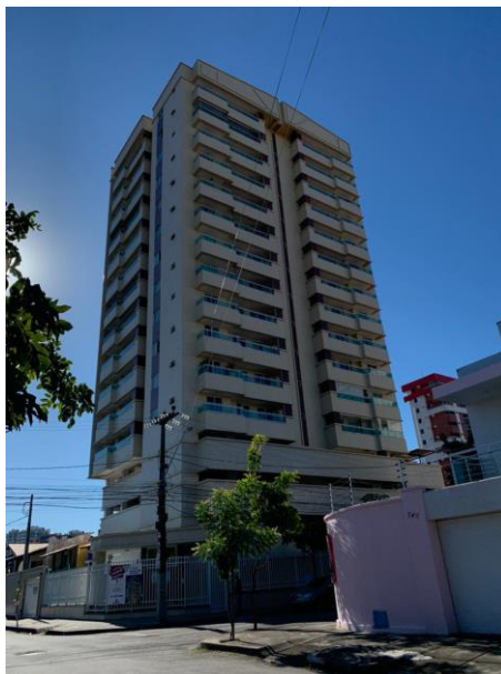
Figura 11 – Foto do Edifício 9
