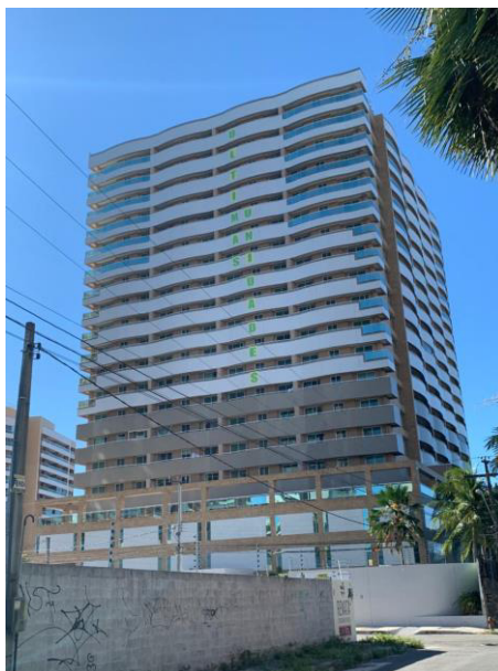
Figura 16 – Foto do Edifício 14
