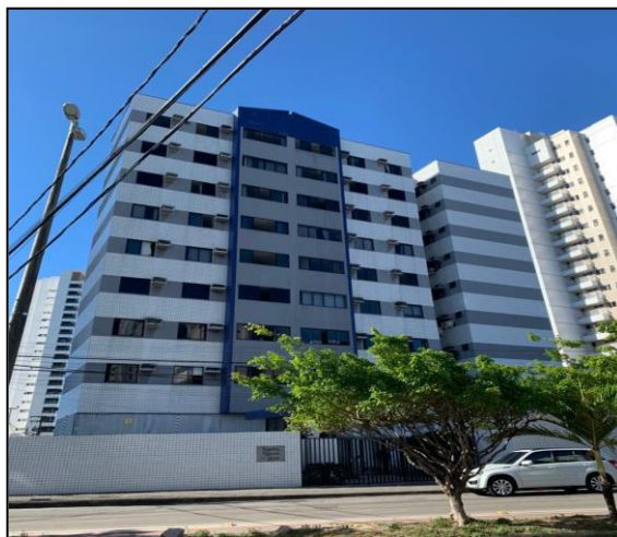
Figura 3 – Foto do Edifício 1
