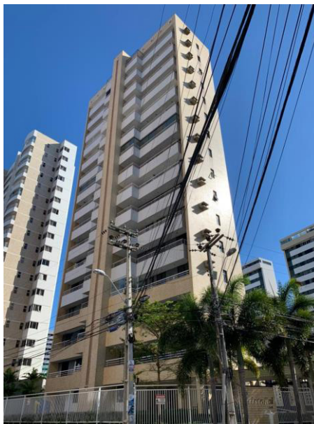
Figura 5 – Foto do Edifício 3
