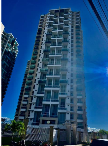
Figura 15 – Foto do Edifício 13
