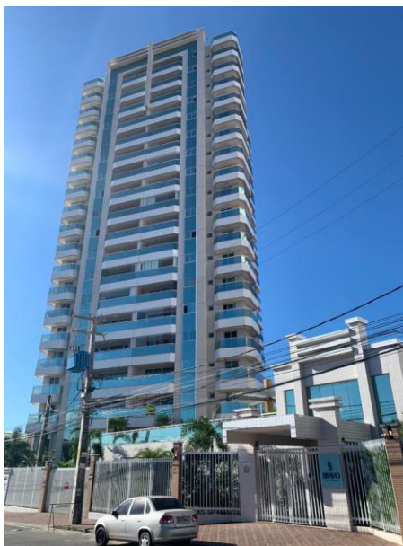
Figura 14 – Foto do Edifício 12
