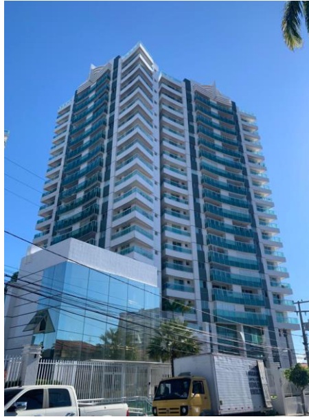
Figura 17 – Foto do Edifício 15
