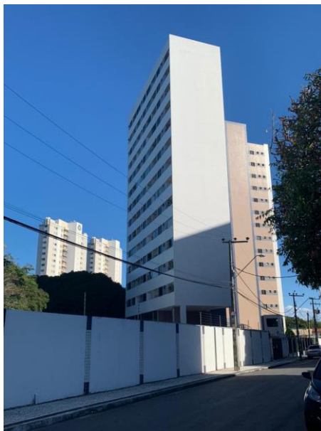
Figura 9 – Foto do Edifício 7
