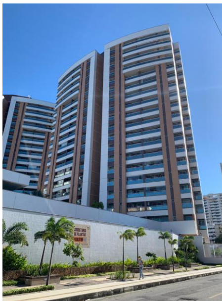
Figura 20 – Foto do Edifício 18
