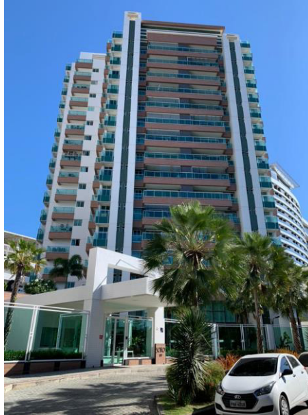
Figura 19 – Foto do Edifício 17
