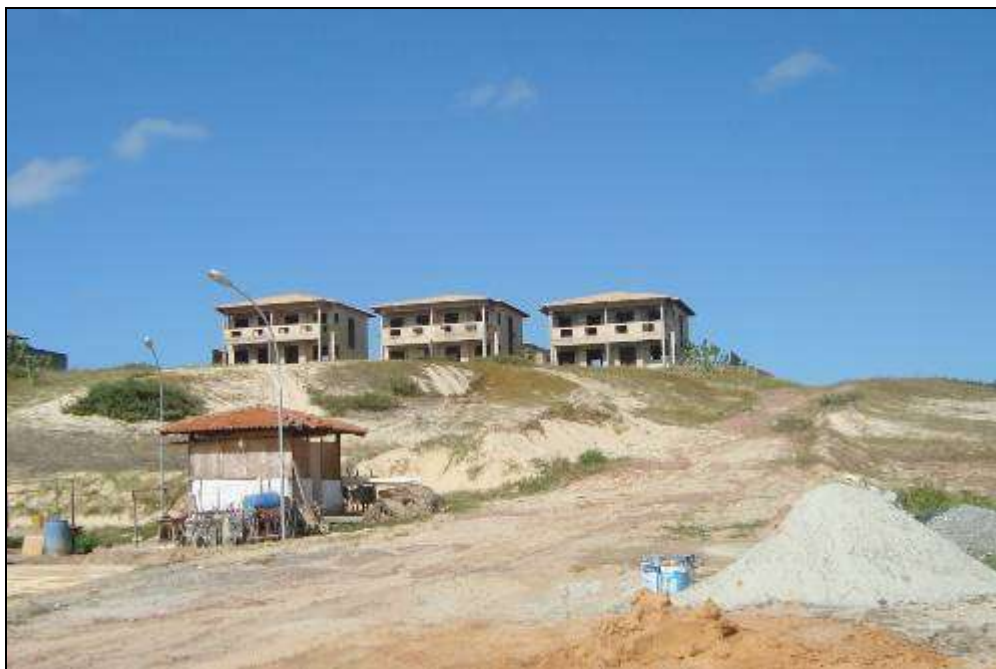
Figura 11 - Parcelamento urbano e construção de empreendimentos tipo condomínio nas Dunas, Porto das Dunas, Aquiraz, CE. Julho de 2010. Acervo do autor.
