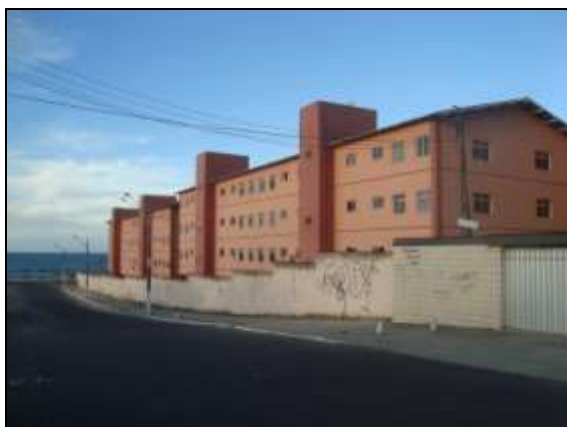
Figura 21 - Condomínio vertical a beira-mar. Icaraí, Caucaia, CE. Julho de 2010. Acervo do autor.
