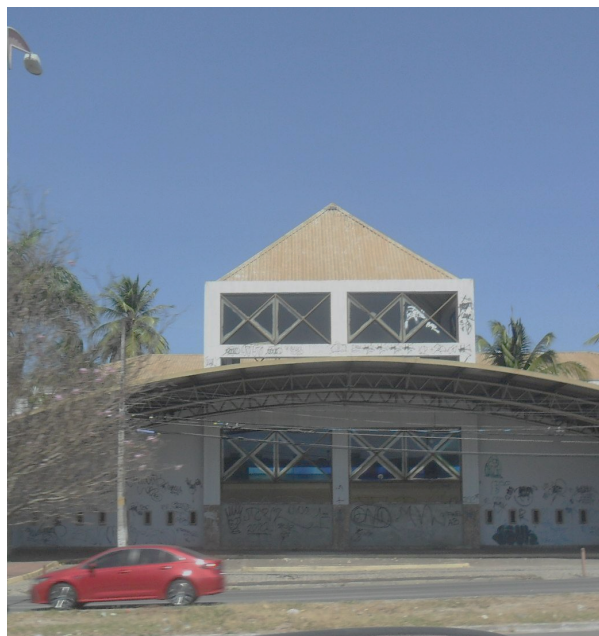
Figura 19 - Siará Hall abandonado.
