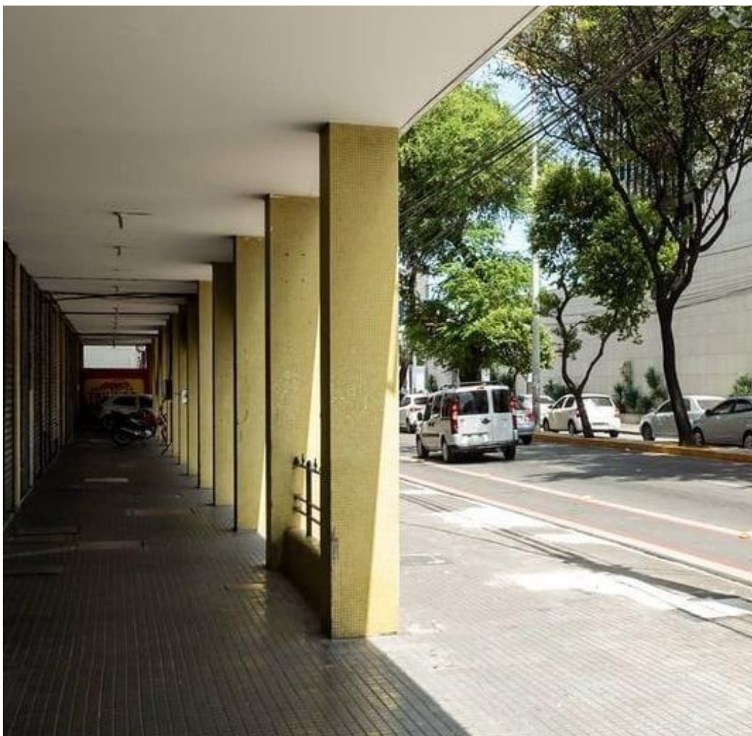
Figura 12 - Edifício Palácio Coronado: pilotis.
