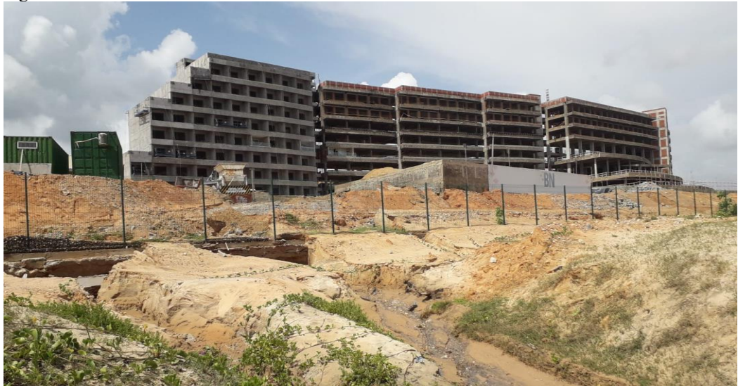
Figura 39 – Obras do Hard Rock Hotel no início de fevereiro de 2023
