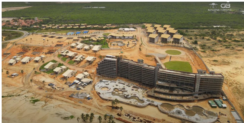
Figura 38 – Vista aérea das obras do Hard Rock Hotel Fortaleza
