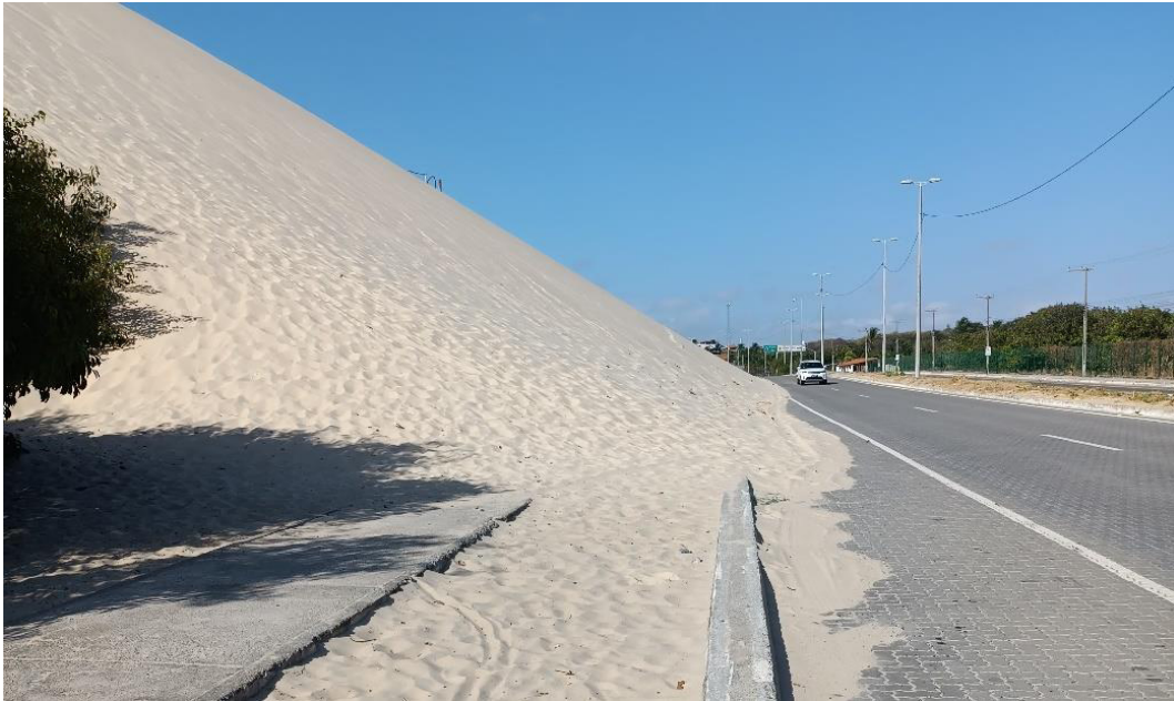
Figura 11 – Sedimentos da duna sendo depositados sobre a CE-010
