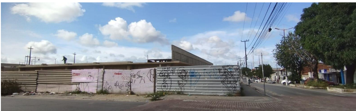
Figura 7: Obra do Mercado da Jurema
