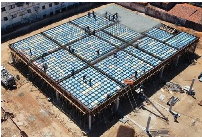
Figura 19 – Solução em laje nervurada com vigas-faixa protendidas
