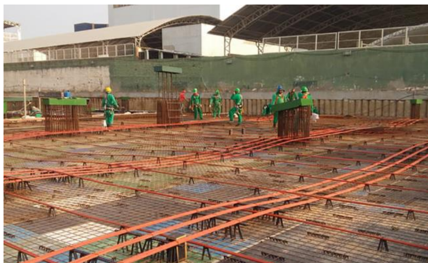
Figura 15 – Solução em laje lisa protendida
