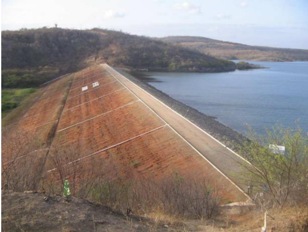
Figura 17 — Vista da barragem Olho D'água.
