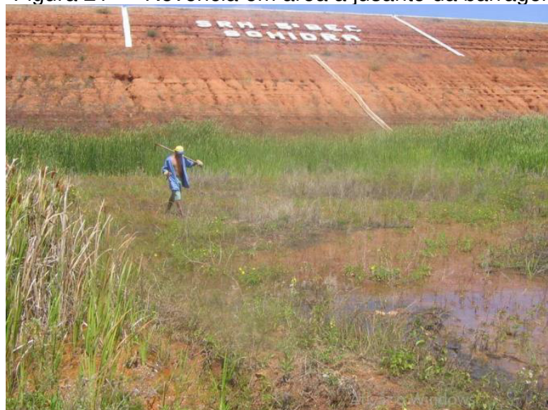
Figura 21 — Revência em área à jusante da barragem.
