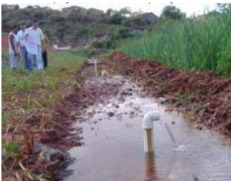
(a) Poço de alívio vista lateral
