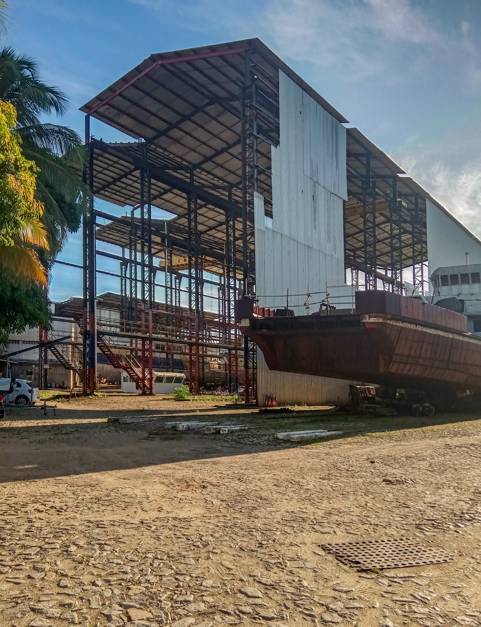
FIGURA 21 - VISTA INTERNA DO TERRENO DA INACE - GRANDE GALPÃO FONTES: ACERVO AUTORAL
