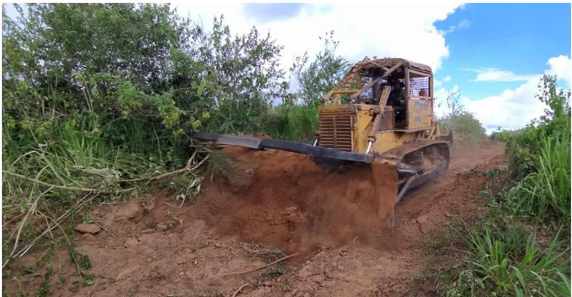
Figura 7. Reforma de caminhos no interior da fazenda e suas divisões. Arame (MA), 2020.
