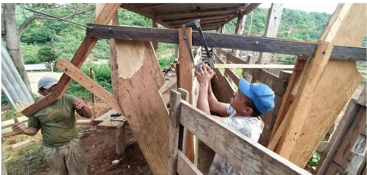
Figura 12. Instalação das pescoceiras no curral. Arame (MA), 2020.
