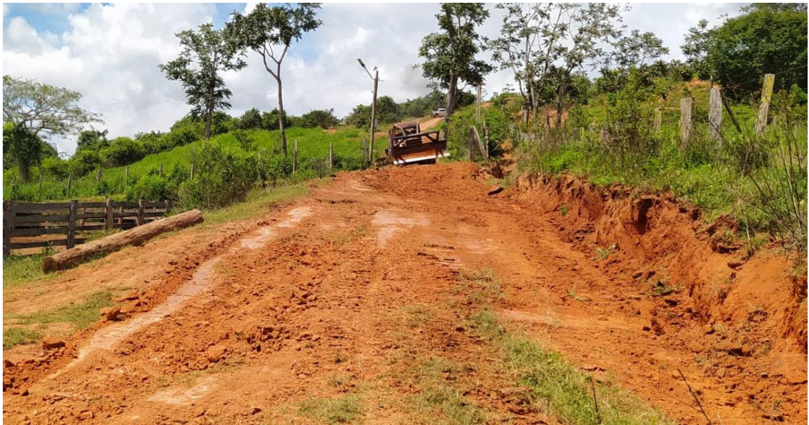
Figura 6. Reforma das estradas e caminhos de acesso à fazenda. Arame (MA), 2020.
