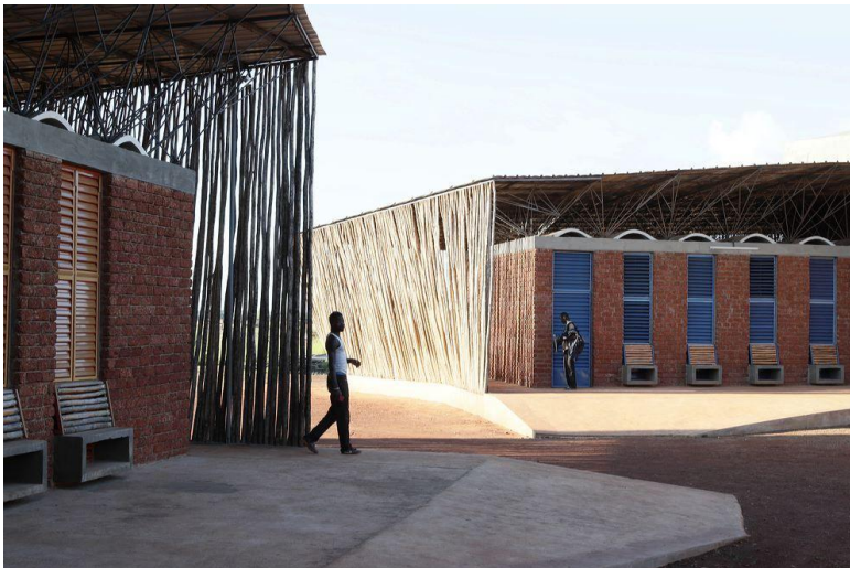
Imagens 92 e 93: Escola Secundária Lycée Schorge. Fonte: Archdaily.
