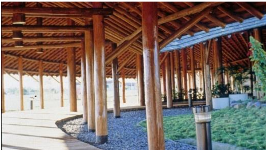
Imagem 91: Estrutura complexa da coberta e jardim. Fonte: Vitruvius.
