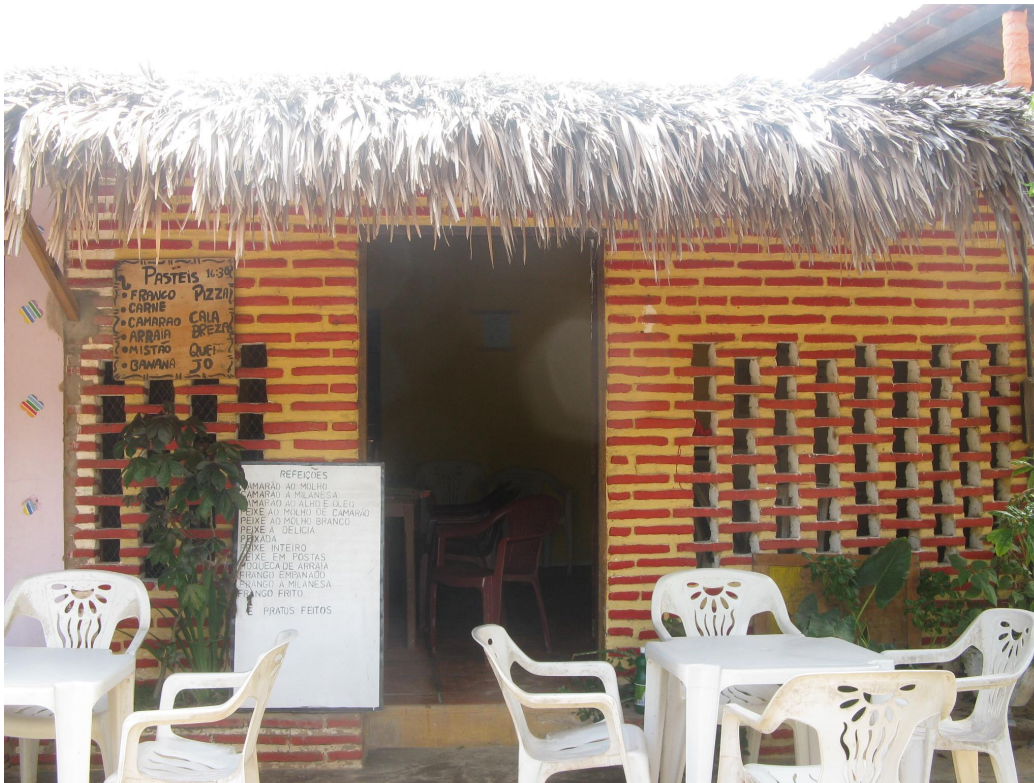
Imagem 70 - Aberturas para ventilação, coberta de palha de carnaúba. Fonte: Acervo de Esteban Franich, 2000.
