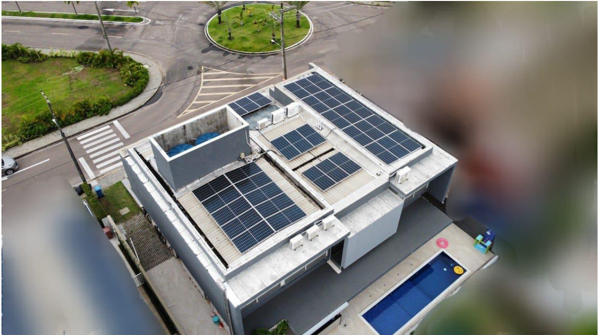
Figura 18 - Foto aérea da residência pós-obra concluída.
