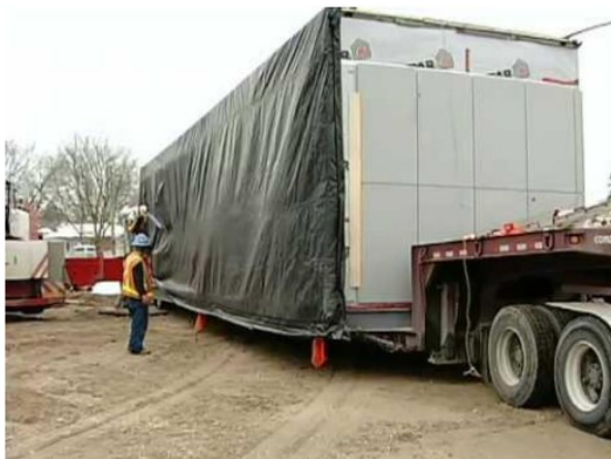
Figura 19 - Módulo preparado para transporte.
