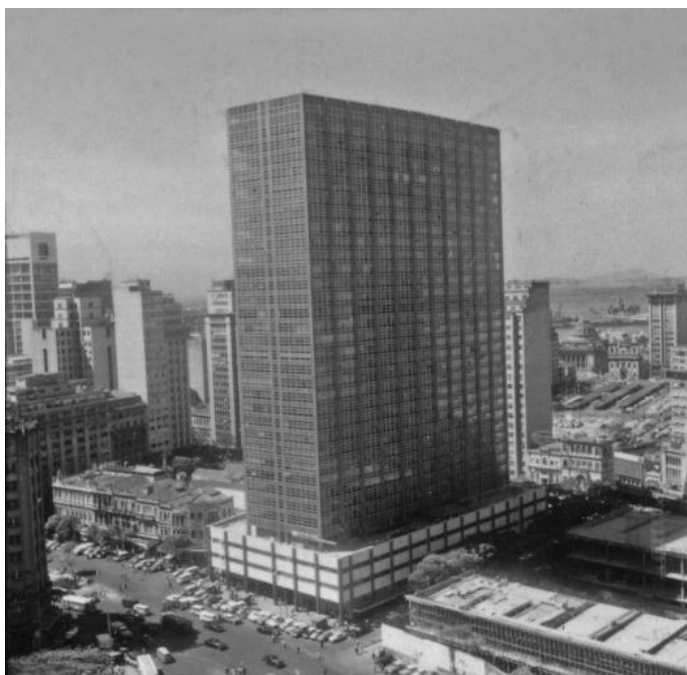
Figura 02 – Edifício Avenida Central.
