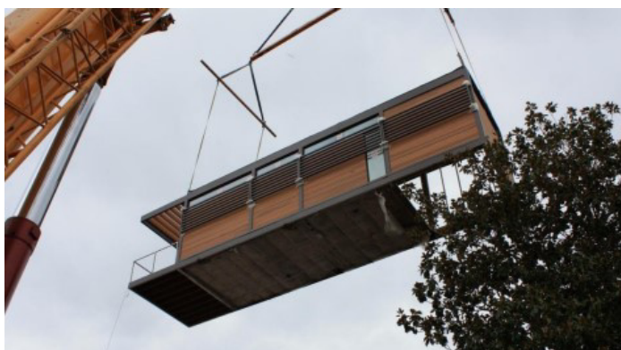
Figura 20 – Guindaste posicionando módulos de Light Steel Frame
