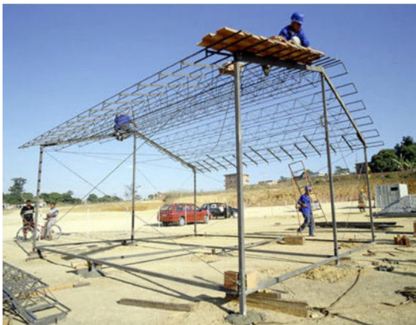
Figura 07 - Kit Casa Fácil Gerdau montado.
