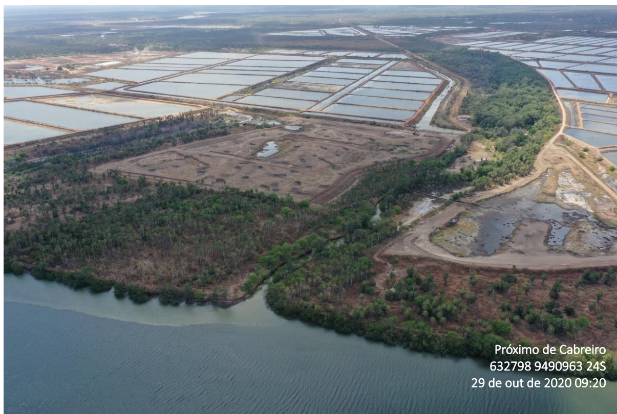
Figura 28 – Fotografia aérea obtida por drone em 28/10/2020 da disposição de efluentes de uma fazenda de carcinicultura no município de Aracati – CE.
