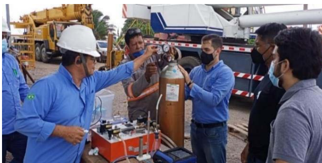
Figura 33 - Ajuste de pressão e de vazão no cilindro STAR GOLD – White Martins®.
