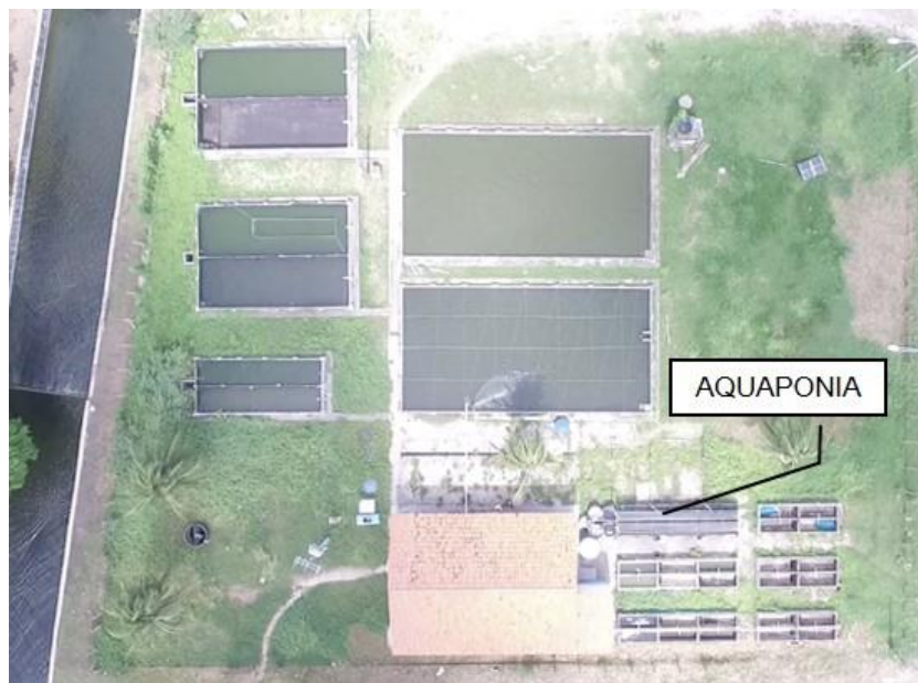
Figura 7 – Vista aérea da Estação de Aquicultura da Universidade Federal do Ceará - Campus do Pici .
