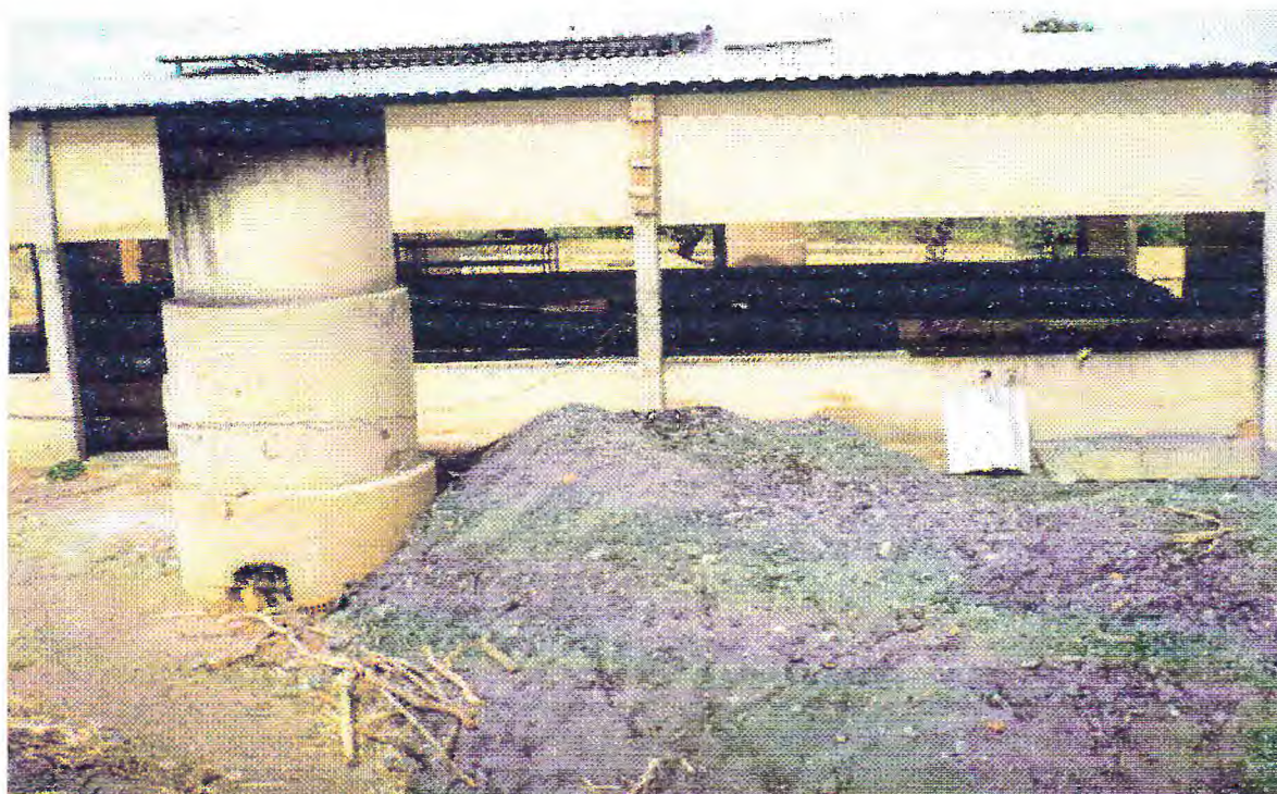
FIGURA 11 - Chaminé, cinzas e vista parcial do Engenho Santana.
