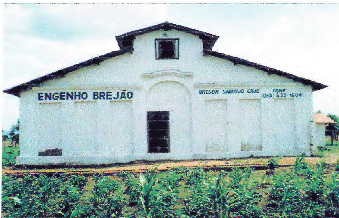
FIGURA 5 - Engenho Brejão, vista frontal do prédio principal
