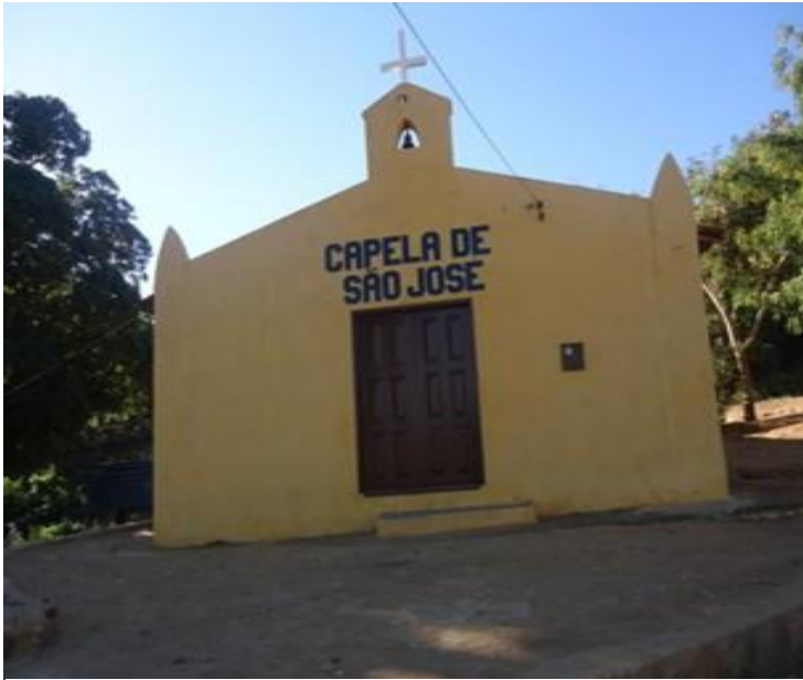
Figura 9- foto: “Capela de São José antes da reforma”, ano 2019 Fonte: Google
