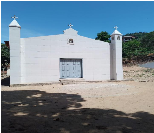
Figura 10- foto: “Capela de São José depois da reforma”
