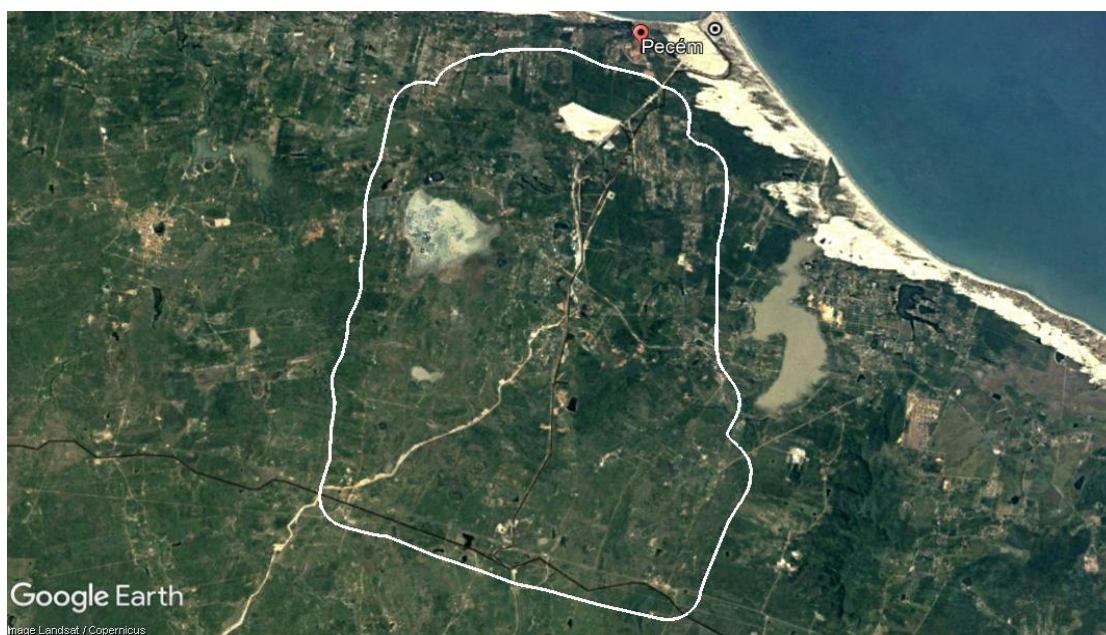
Figura 15: Desenvolvimento das Obras da CIPP – Ano 2000
