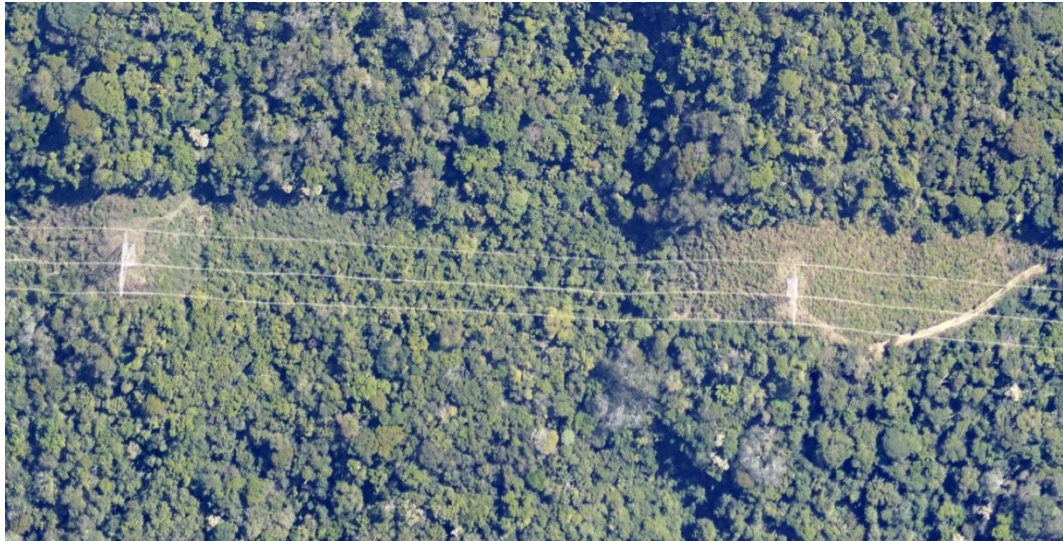
Figura 2: Implantação de uma Linha de Transmissão.
