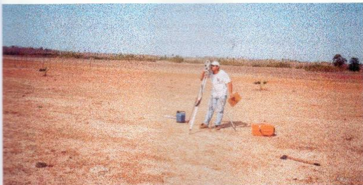
Figura 2 - Execução dos serviços topográficos
