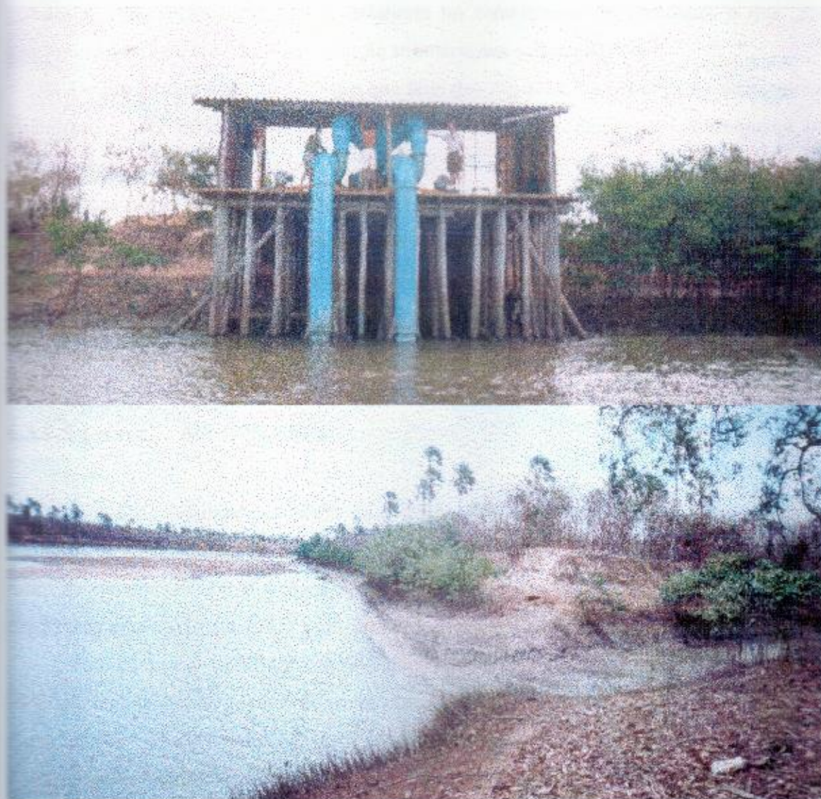
Figura 25 – Casa de bombas. Aproveitamento de porto existente e uso de recursos locais na construção.
