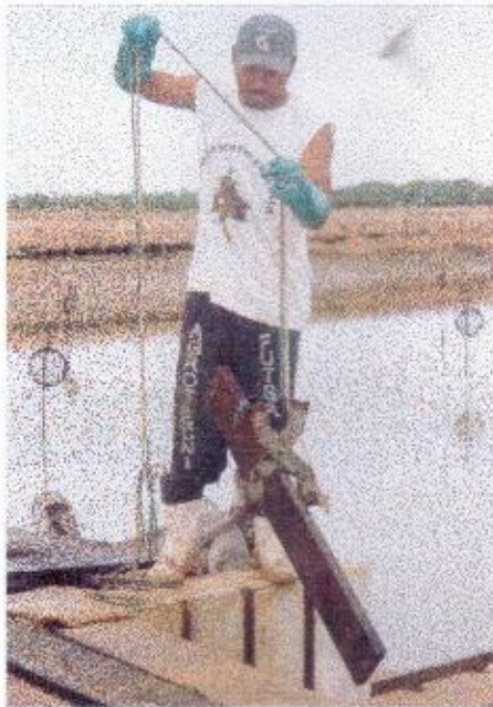
Figura 10 – Retirada do “stop” de uma comporta com o auxílio da tesoura gancho.
