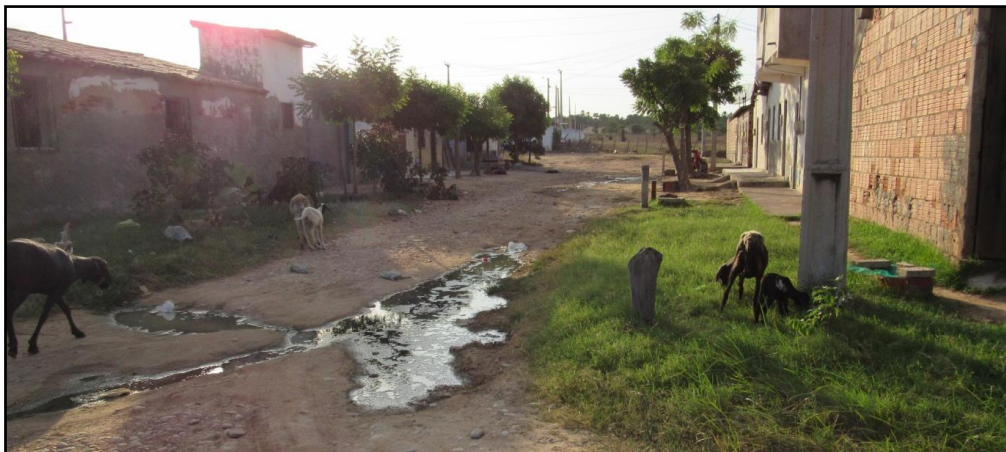
Figura 25 – Esgoto a céu aberto das residências na localidade de Alto do São João.
