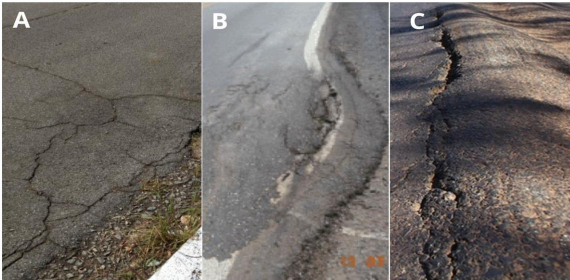
**Figura 1.** (A) Defeitos de superfícies; (B) Degradações superficiais; (C) Deformações.
