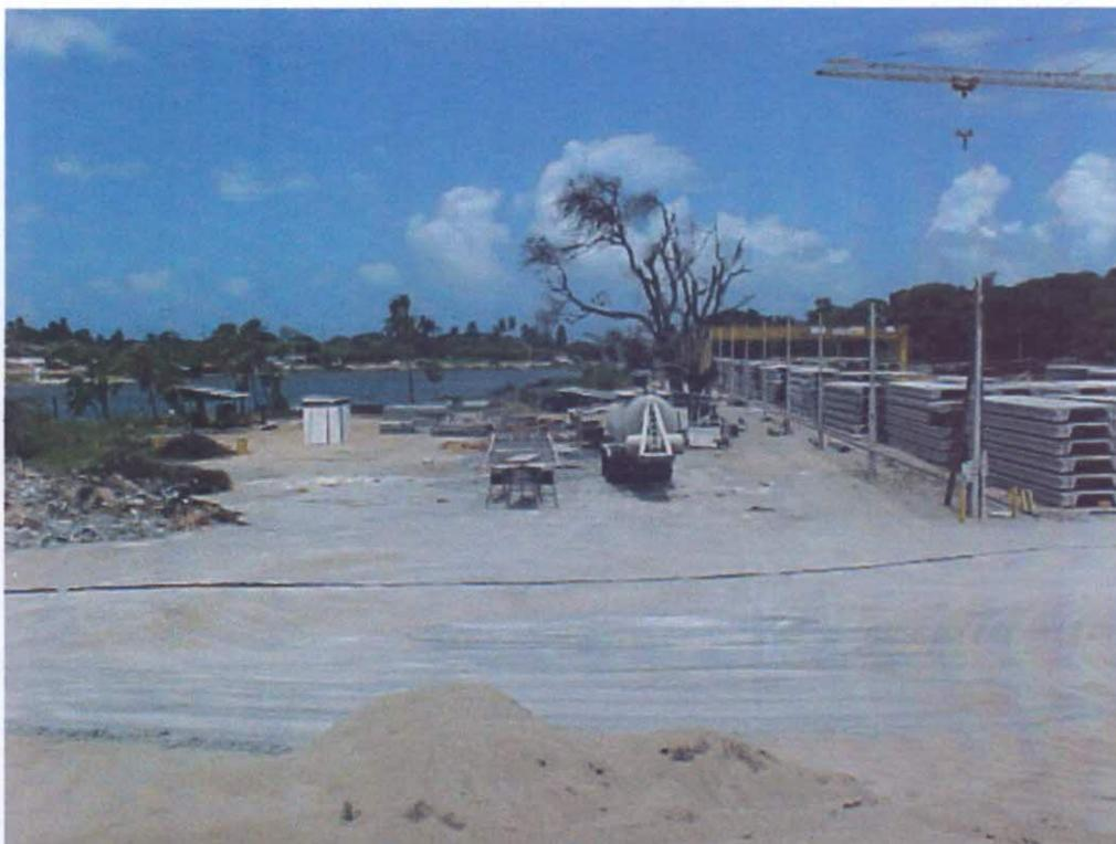
Foto 5 – Vista da área da Lagoa do Tabapuá, onde foi instalada o Pátio de Pré-moldados. Em 1º Plano observa-se a área concretada às margens da lagoa, à direita as placas pre-moldadas das paredes diafragmas.
