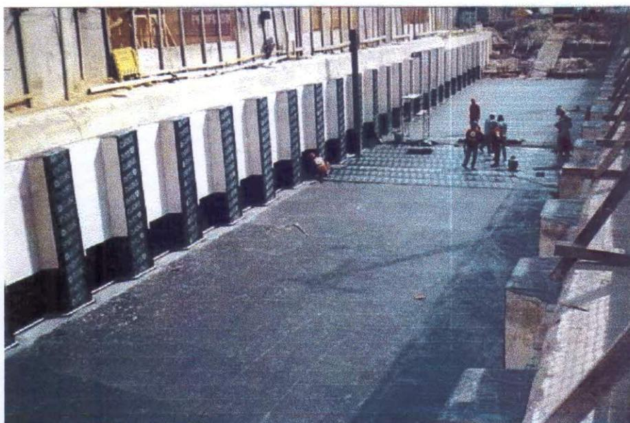
Foto 11: Impermeabilização da laje superior do túnel.
