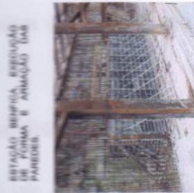
ESTAÇÃO BENFICA, EXECUÇÃO DE FORMA E ARMAÇÃO DAS PAREDES
