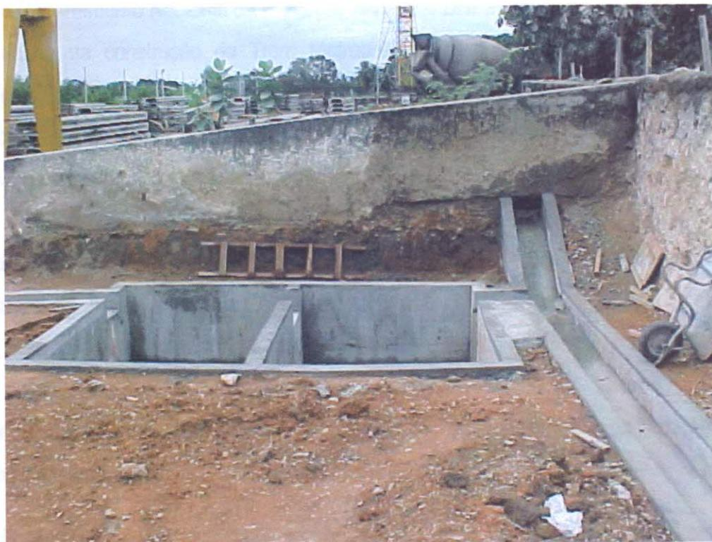
Foto 7 – Vista dos tanques de decantação, evitando que águas com cimento ou concreto possam seguir para a drenagem superficial.
