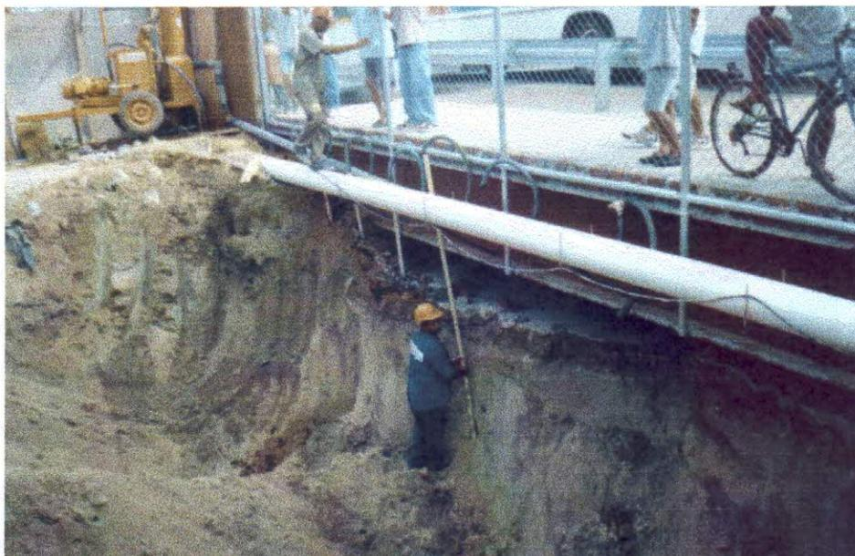
Foto 09: Colocação de conjunto de ponteiras no trecho escavado até 2,5 metros, na Av. Carapinima.
