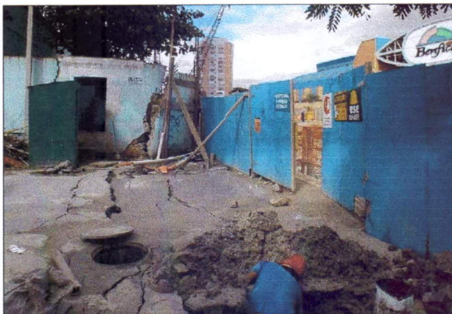
Foto 16: Deformações no terreno adjacente às escavações para a execução da laje de cobertura, na Av. Imperador.
