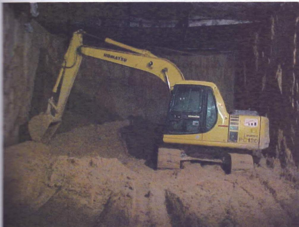
Fig. 11 - Escavação realizada no túnel do Trem Metropolitano de Fortaleza, nos sedimentos da Formação Barreiras. Em 2º plano observa-se o perfil dos sedimentos areno-argilosos com níveis conglomeráticos a uma profundidade de 09 metros.
