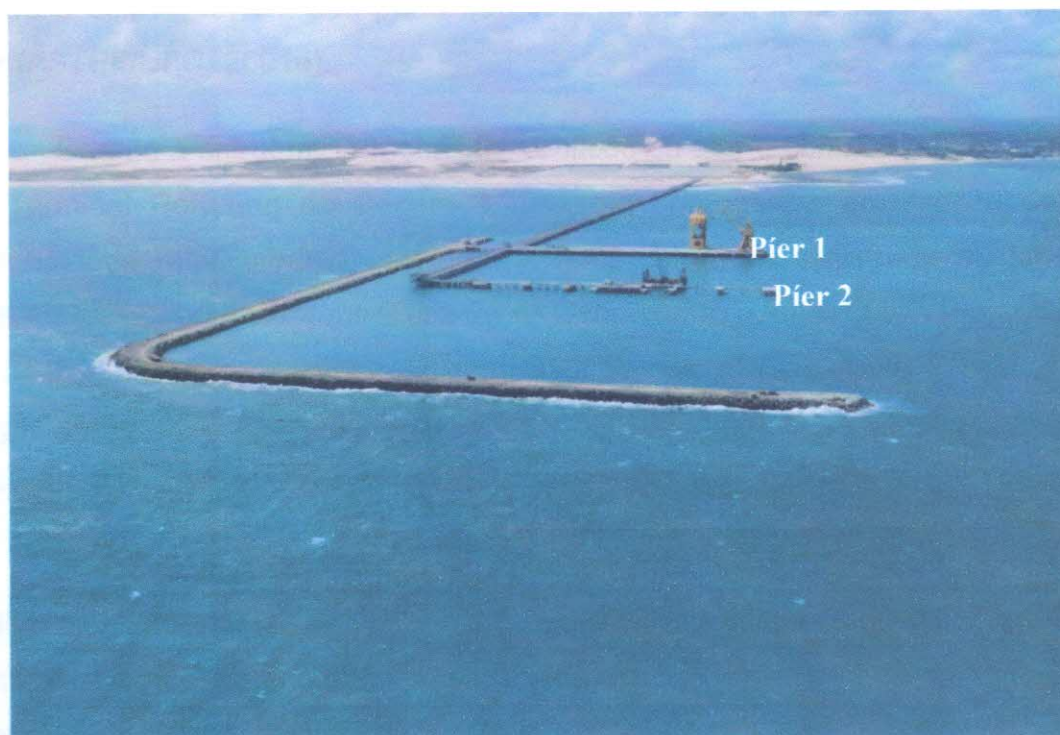
Figura 5 - Áreas de estudo no Terminal Portuário do Pecém, Ceará. Piers 1 e 2 para atracação de navios e áreas a barlavento e sotavento do quebra-mar de proteção (Arquivo SEINFRA).
