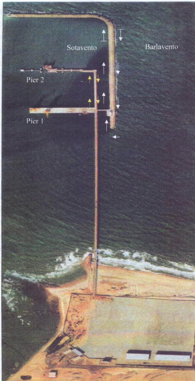
Figura 6 – Trajetória dos mergulhos no Terminal Portuário do Pecém nos pilares entre os píers 1 e 2 (setas amarelas), a barlavento e sotavento do quebra-mar (setas brancas).
