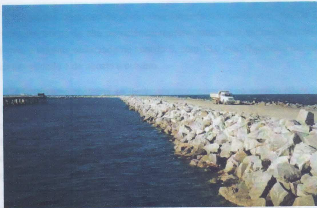
Figura 4 – Quebra-Mar offshore do Terminal Portuário do Pecém, Ceará (Arquivo SEINFRA).
