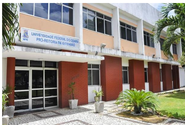
Figura 2 – Fachada do prédio da PREX.
