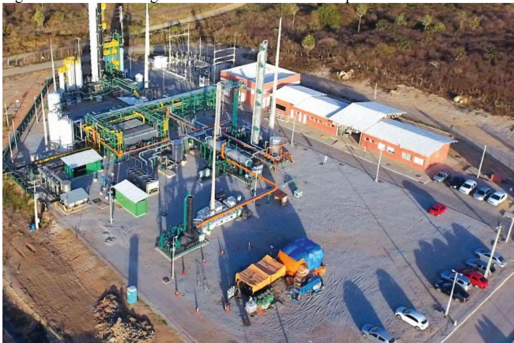
Figura 9 – Usina de biogás do Aterro Sanitário Municipal Oeste de Caucaia
