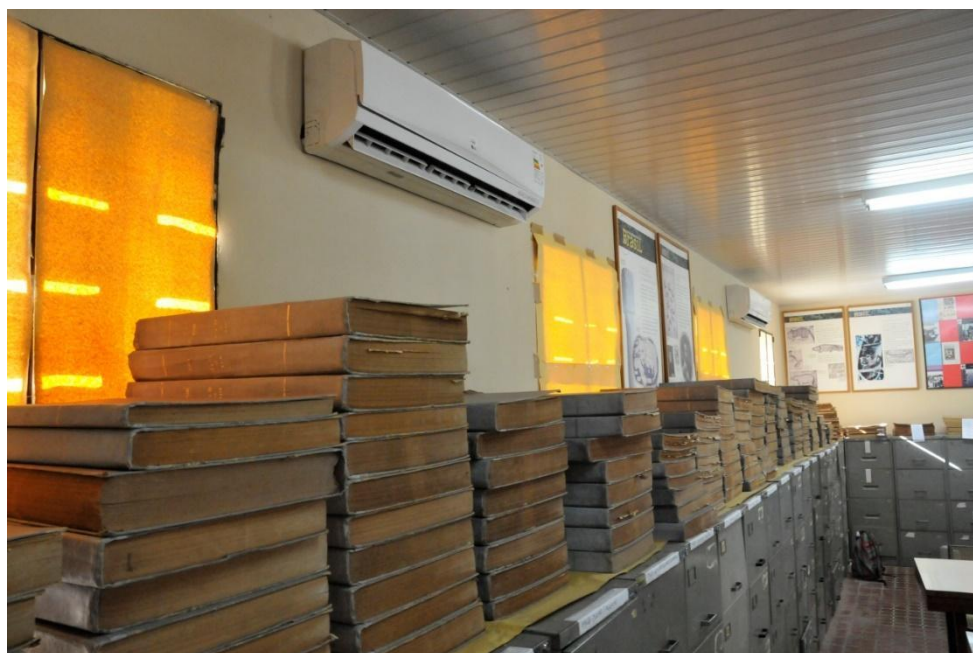
FOTO 10 – Forro no teto propiciando aumento de temperatura no acervo FONTE: Equipe do Memorial no acervo do NUDOC. Fotógrafo: Arlindo Barreto – Memorial UFC
