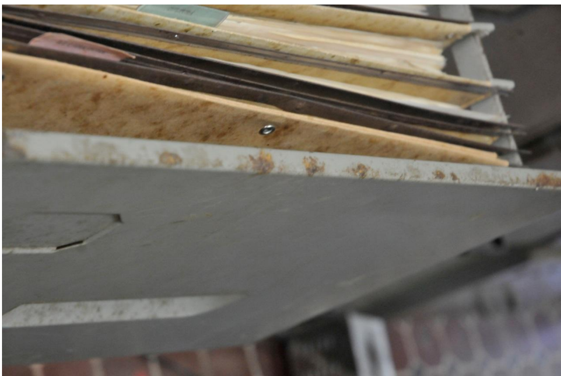
FOTO 1 – Aspecto corrosivo de estantes metálicas do acervo do NUDOC
