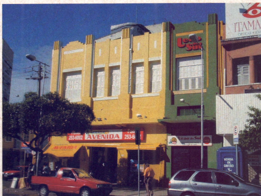
Figura 75 Farmácia e lanchonete, fachadas renovadas, Praça do Ferreira, Centro. Foto da autora, junho de 2004.
