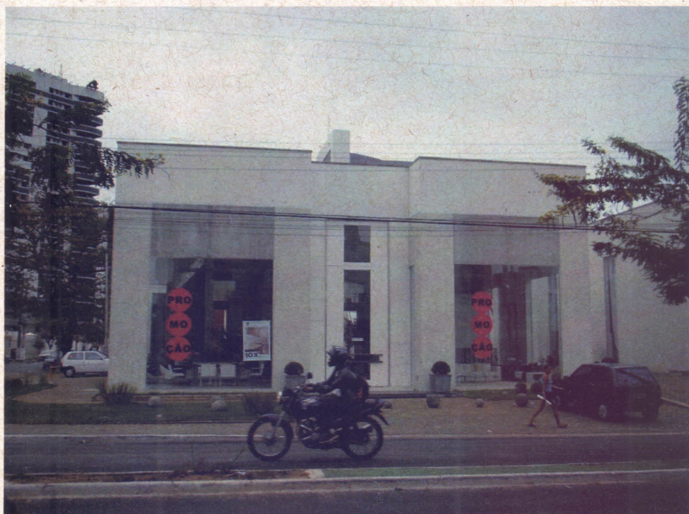
Figura 52 Loja Rônega, de móveis, com duas vitrinas do tipo abertas. Local: Avenida Senador Virgílio Távora, em Fortaleza, foto da autora, janeiro de 2004.
