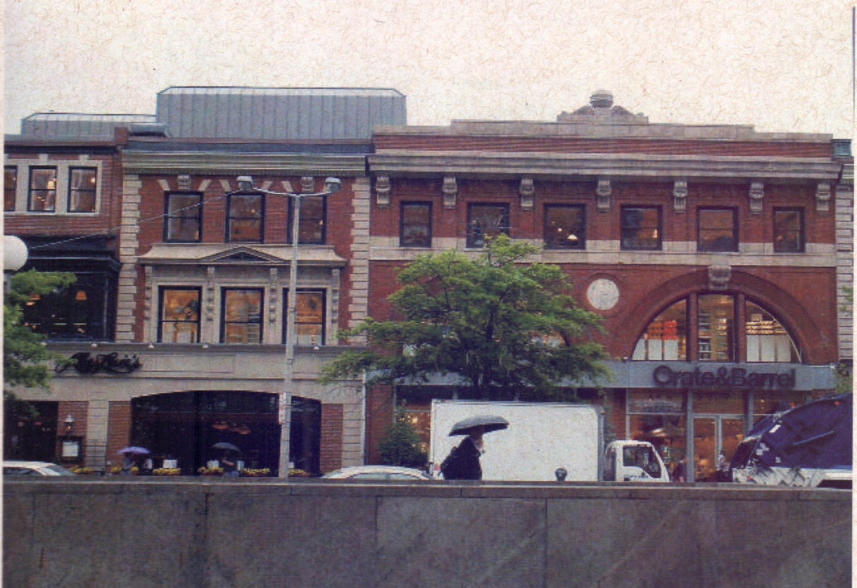
Figura 44 Loja Crate & Barrel, fachada assimétrica. Local: Downtown de Boston, EUA, maio de 2002, foto da autora.
