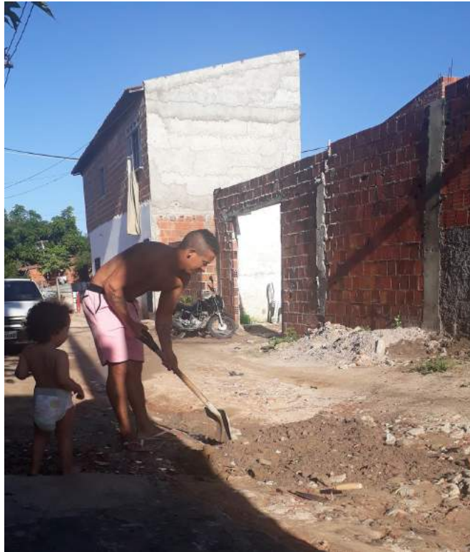
Figura 16: Morador da comunidade realizando reparo de um cano exposto em frente a sua residência. Data: 02/2022. Fonte: arquivo pessoal.
