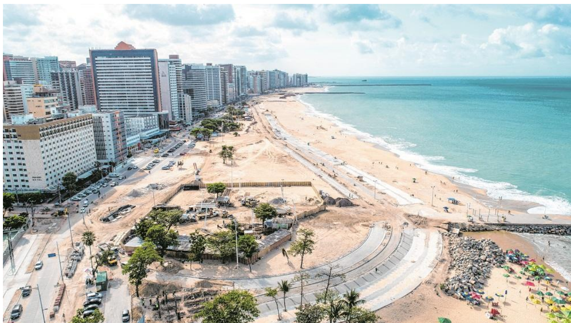
Figura 13 - Esplanada do Espigão da Avenida Desembargador Moreira em obras
