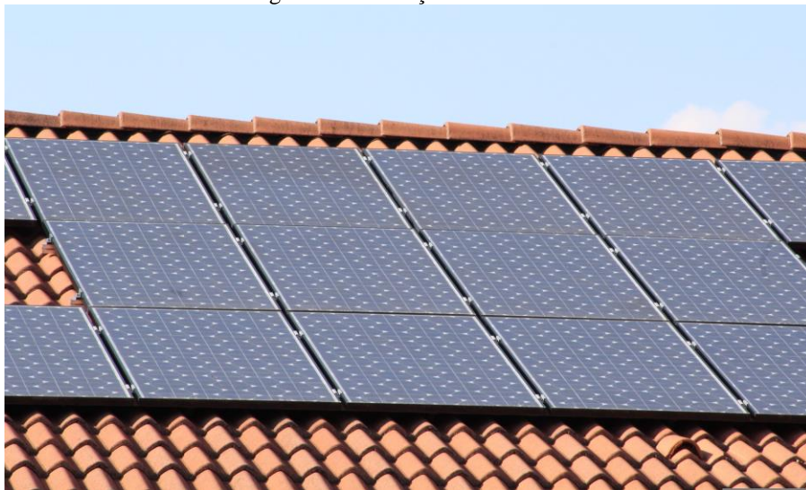
Figura 6 – instalação em telhado.
