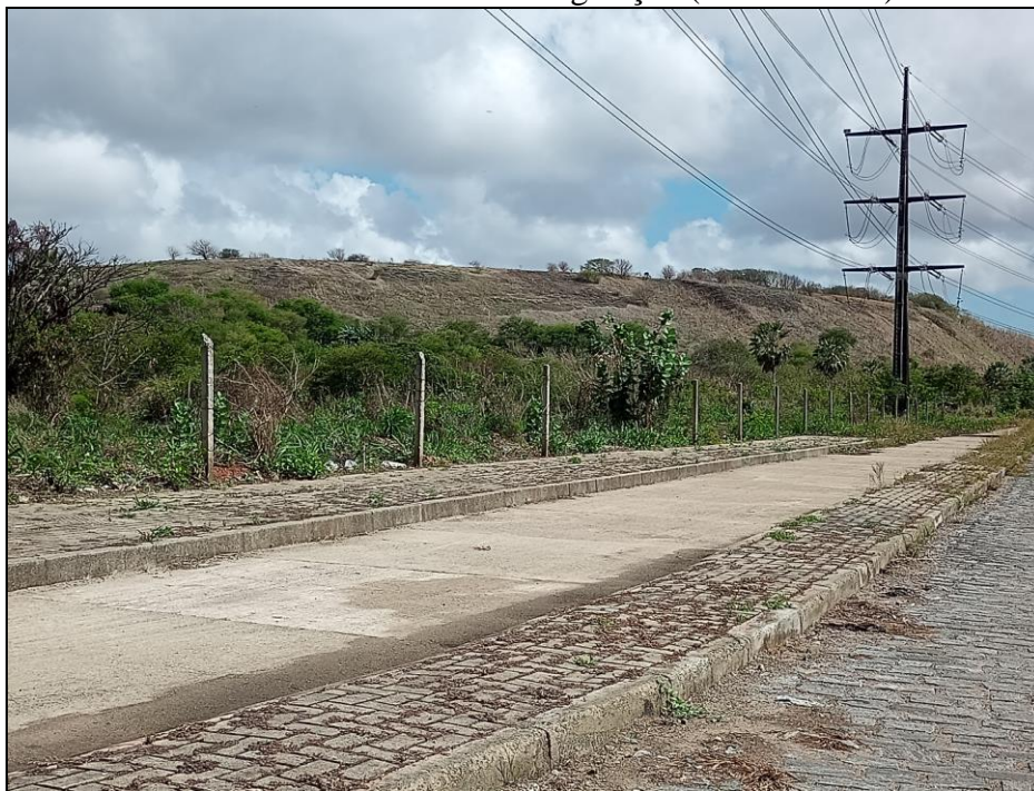
Figura 36: Aterro do Jangurussu – bairro Jangurussu, recoberto com sedimentos Barreiras e com vegetação (Janeiro/2023)
