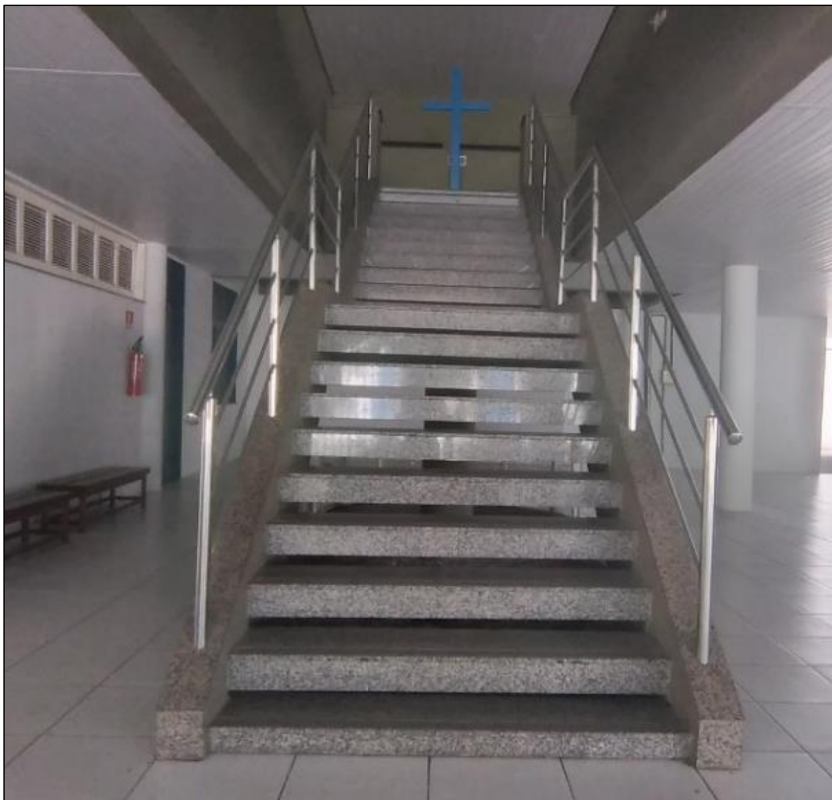
Figura 29 – Acesso ao 2º piso da sede da Nova Comunidade Católica Rainha da Paz
