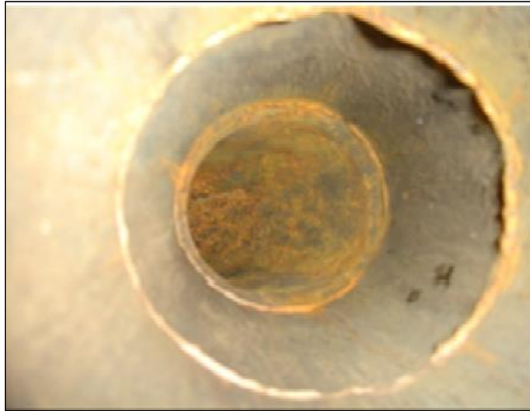
Figura 22. Tubulação depois da remoção.
