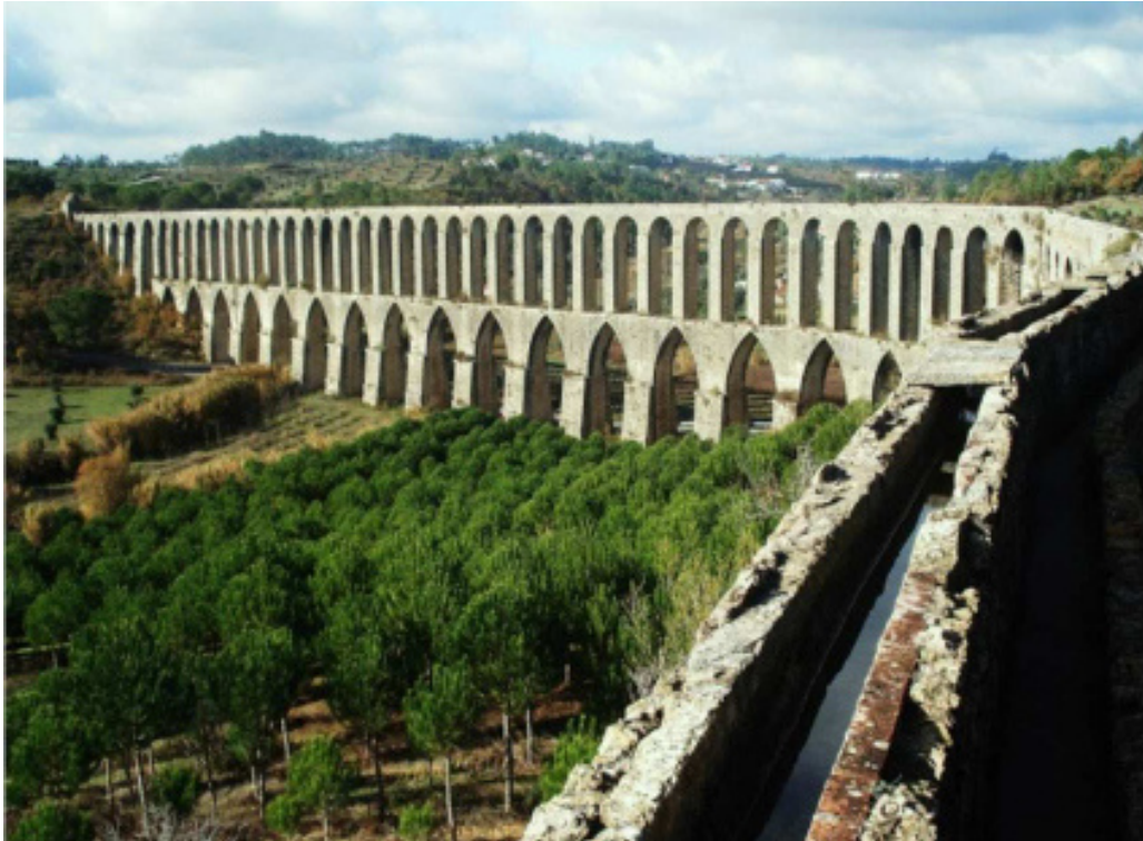
Figura 1: Aquedutos públicos construídos em meados dos anos 50 d.C., localizado na região metropolitana Roma, em 2007.
