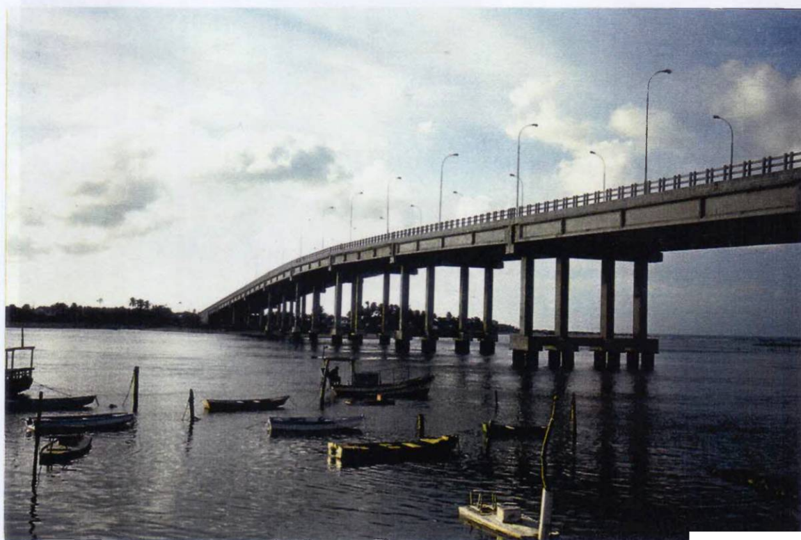
FOTO 7 - Ponte Sobre o Rio Ceará. Detalhe da estrutura. Fortaleza, 1999.
