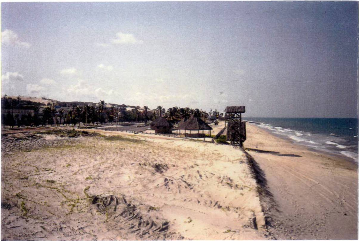
FOTO 13 - Caesar Tower's Resort. Detalhe do avanço sobre a praia. Porto das Dunas, 1999.
