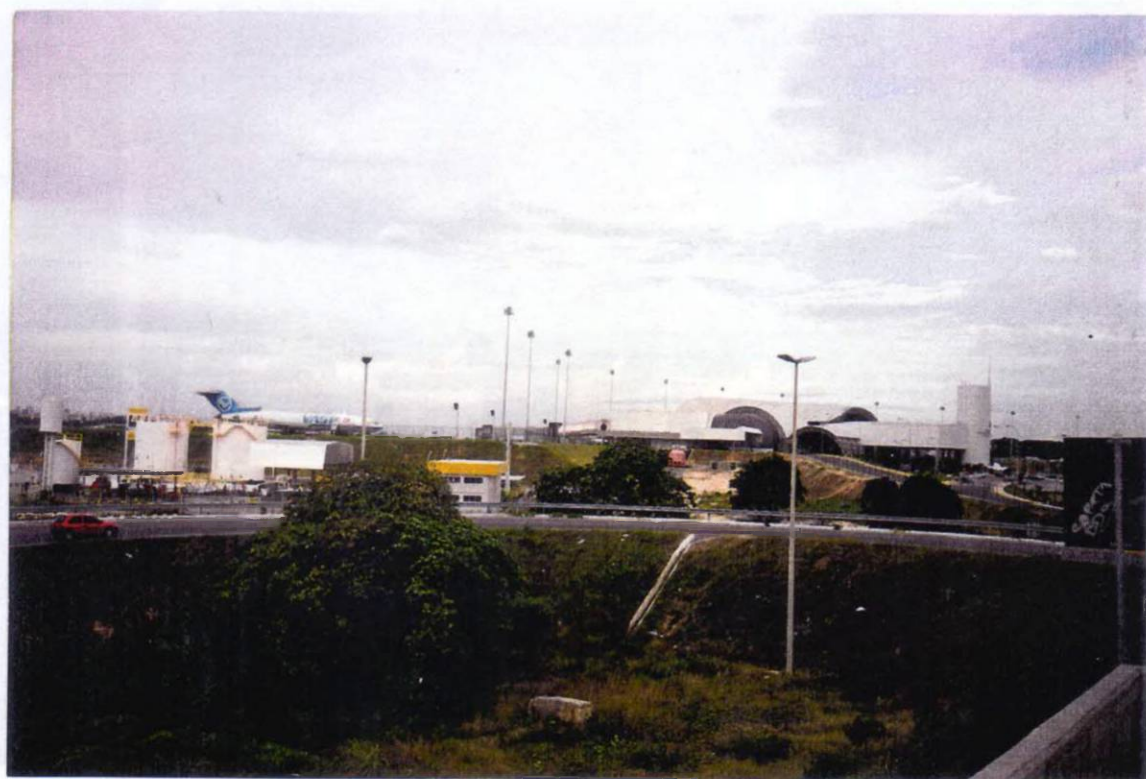
FOTO 2 - Aeroporto Internacional Pinto Martins. Vista lateral. Fortaleza, 1999.
