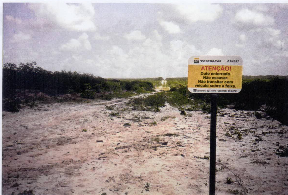
FOTO 9 - GASFOR. Gasoduto Guamaré – Fortaleza. Detalhe da sinalização da localização e cuidados com o duto. Aracati, 1999.
