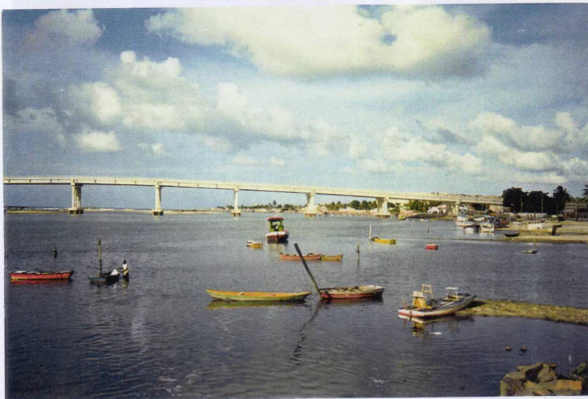
FOTO 6 - Ponte Sobre o Rio Ceará. Vista geral da ponte. Fortaleza, 1999.
